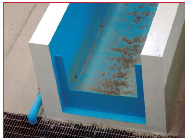
Ilustración 5.2 Ejemplo de vertedor rectangular a base de placa de acero
