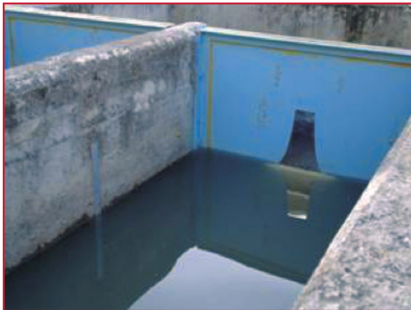
Ilustración 5.9 Montaje de vertedores Sutro
