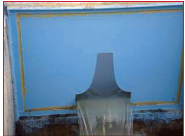
Ilustración 5.10 Uno de los vertedores en operación
