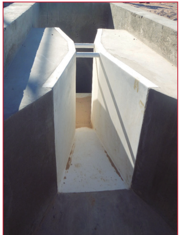
Ilustración 5.15 Instalación de canaleta Parshall en una planta de tratamiento de aguas residuales
