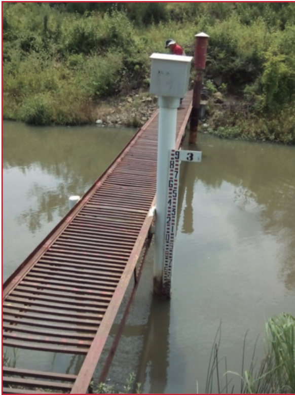
Ilustración 6.9 Pozo Tranquilizador para limnógrafo
