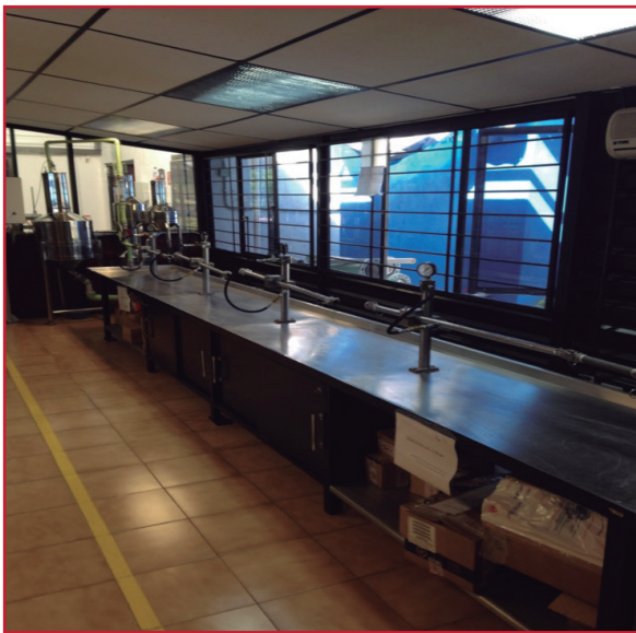
Ilustración 11.26 Banco de pruebas de medidores del IMTA
