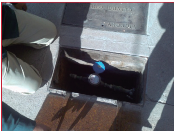
Ilustración 11.19 Instalación de medidor en registro de banqueta
