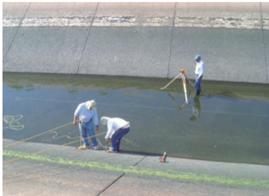
a) Medición de la sección de un canal
