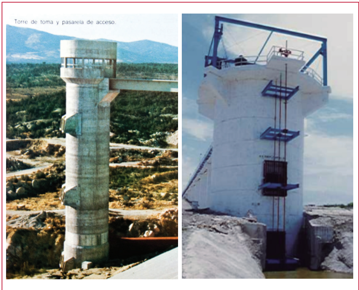
Ilustración 4.26 Obra de toma múltiple
