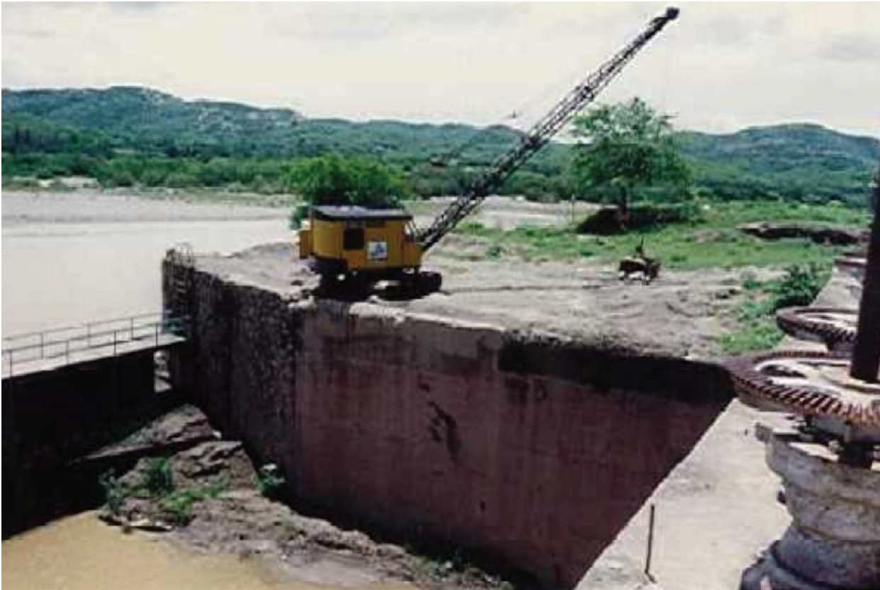
Ilustración 4.4 Obra de toma directa en río (alternativa 2)
