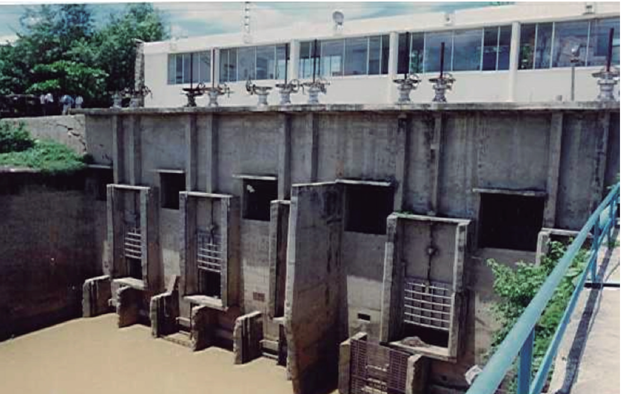
Ilustración 4.4 Obra de toma directa en río (alternativa 2)
