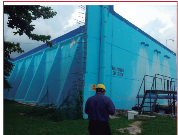
Ilustración 7.4 Ejemplo de contrafuertes exteriores
