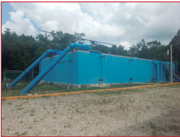
Ilustración 7.12 Ejemplo de tanque de concreto con cubierta
