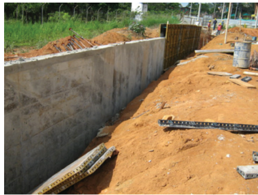
b) Muro de semi-gravedad
