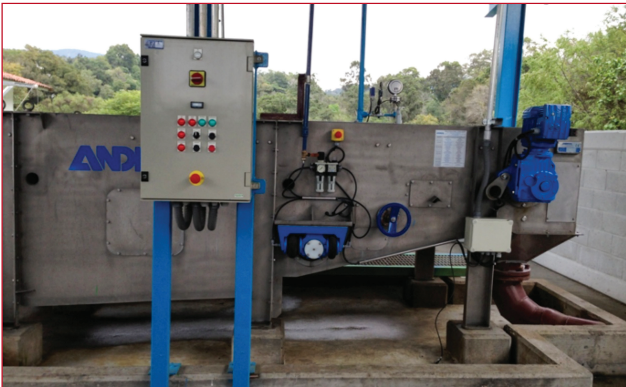
Ilustración 2.18 Espesador de bandas por gravedad
