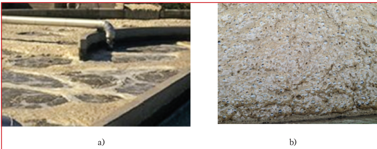
Ilustración 3.23 a) Formación de espuma en un reactor aerobio de lodos; b) espuma
