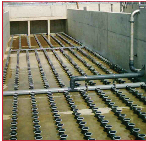
Ilustración 3.1 Sistemas de aeración con difusores
