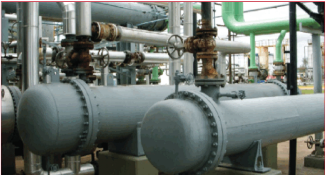
Ilustración 4.18 Intercambiador de calor de carcasa y tubos
