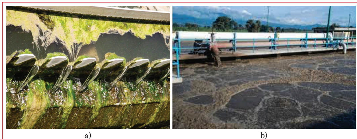
Ilustración 2.17 Problemas que presentan los espesadores, (a) formación de algas y (b) formación de espuma y grasa
