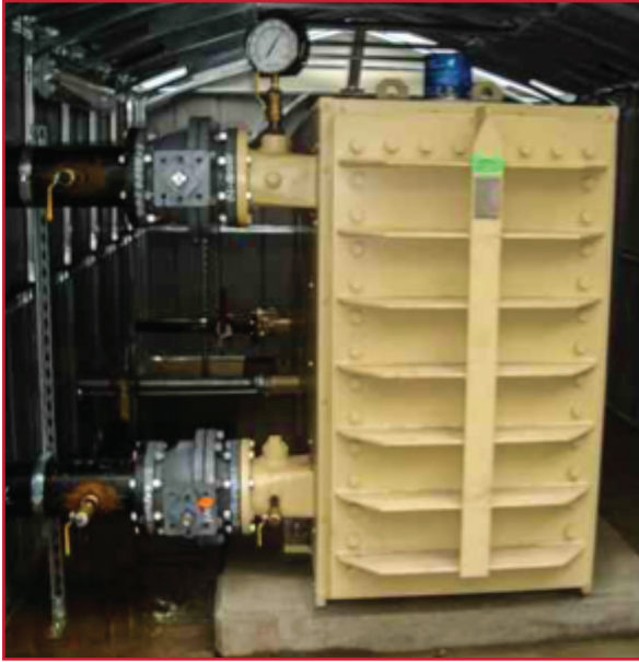
Ilustración 4.21 Intercambiador de calor tipo cubo
