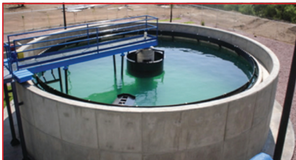
a) Unidad de flotación por aire disuelto
