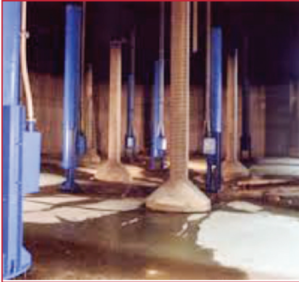
Ilustración 4.13 Sistema de mezclado de pistolas de burbujas
