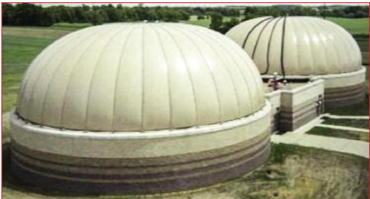
Ilustración 4.6 Cubierta de membrana
