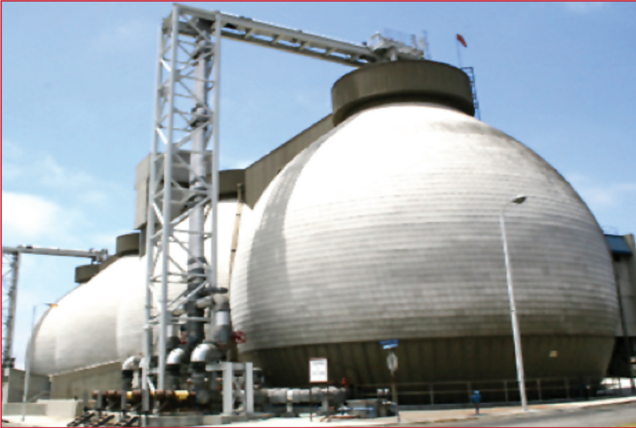
Ilustración 4.4 Reactor en forma de huevo
