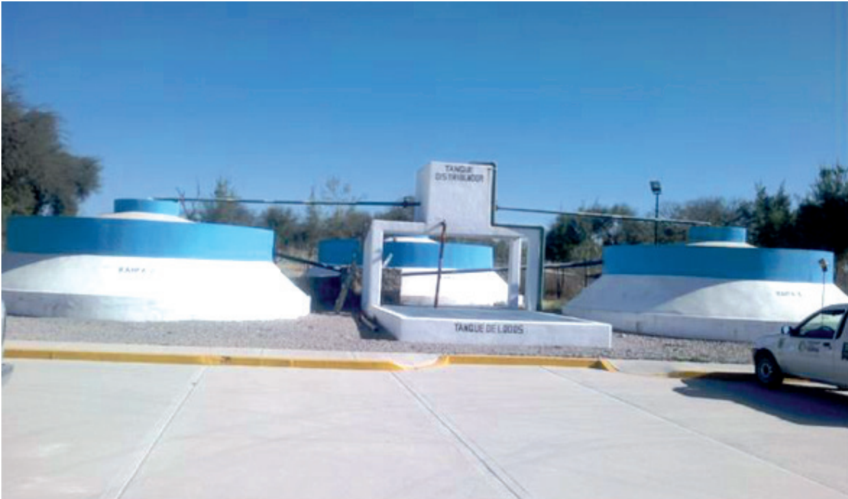
Ilustración 2.3 RAFA en forma de tanque circular
