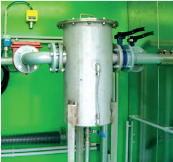
Ilustración 4.10 Trampa de condensados
