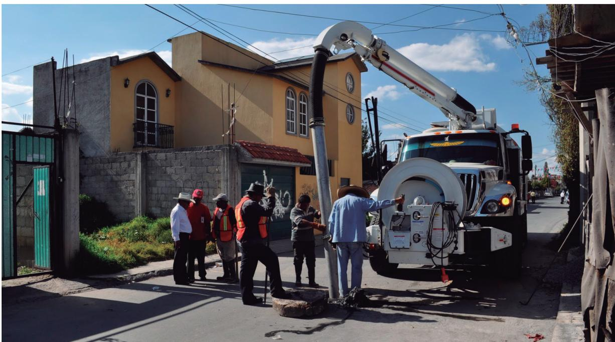
Ilustración 2.19 Equipo de presión y vacío (Adaptado de Vactor®, 2009)
