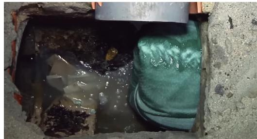
g) Por medio de aire a presión, la manga se inserta en la tubería
