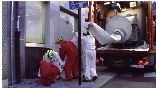
f) Se fija el extremo de la manga a la tubería
