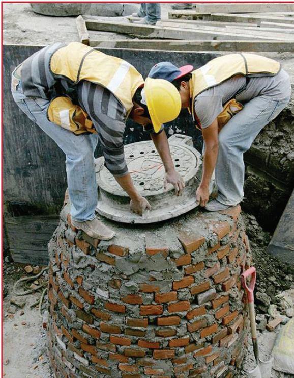
Ilustración 1.4 Colector para una red de alcantarillado sanitario (ODAPAS, Nezahualcoyotl)
