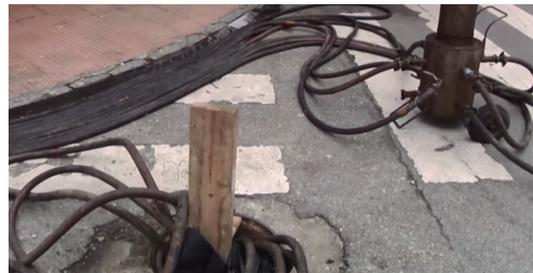
h) La resina se cura por medio de agua caliente, vapor o luz ultravioleta
