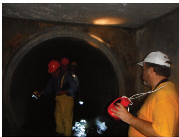
d) Inspección visual en el interior de colector
