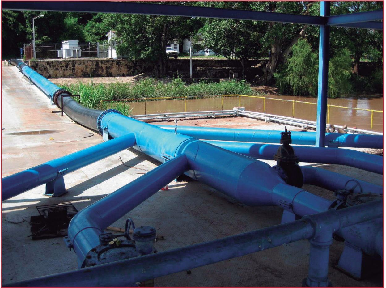
Ilustración 5.47 Ejemplo de múltiples y bridas
