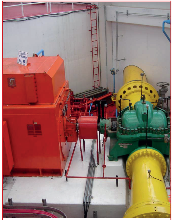
Ilustración 5.12 Bombas con carcasa bipartida
