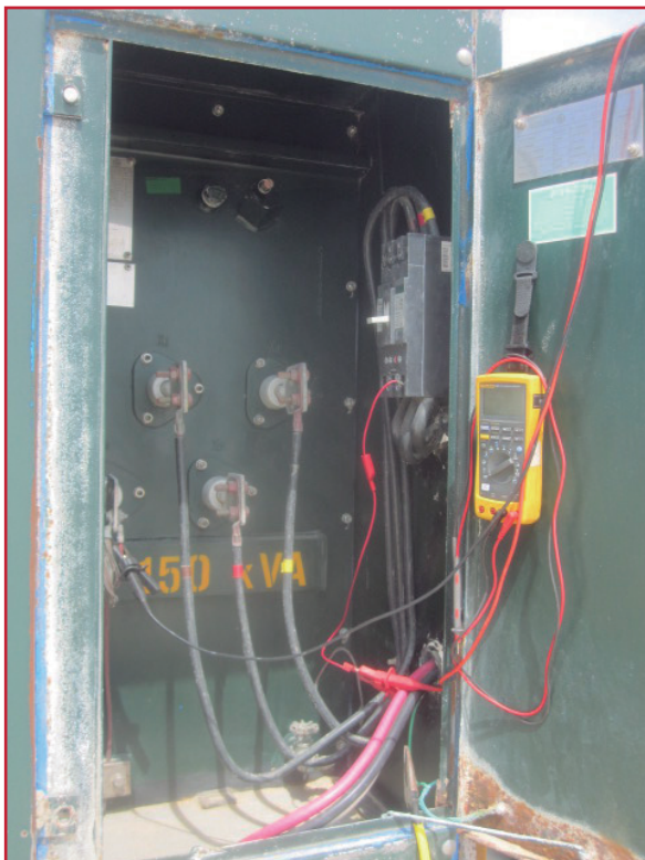
Ilustración 4.1 Medición de tierra en transformador
