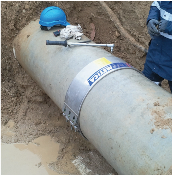
Ilustración 1.24 Reparación de tubería de concreto con elemento mecánico (miraquehacemos.wordpress.com)
