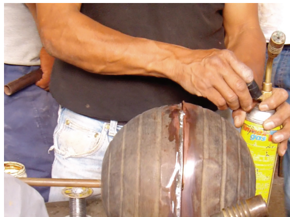
f) Reparación concluida
