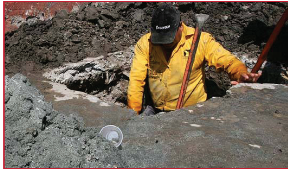
Ilustración 1.48 Excavación de pozo por personal de ODAPAS Nezahualcoyotl
