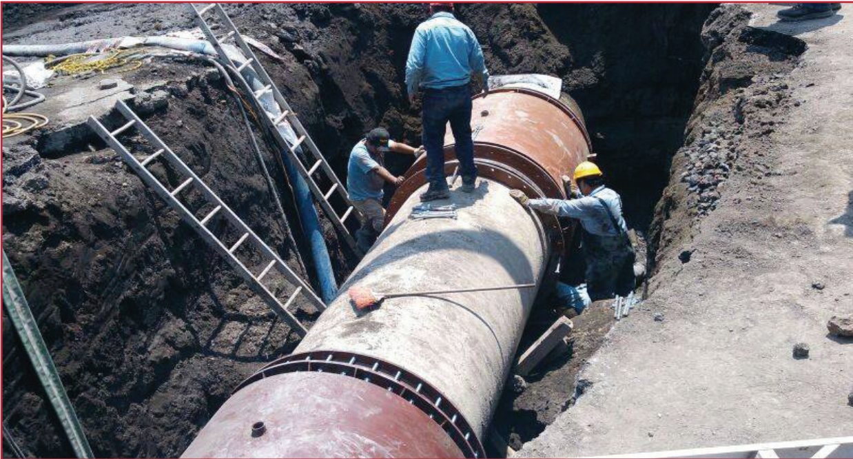
Ilustración 1.15 Personal apretando tornillería de acoplamiento de gran tolerancia
