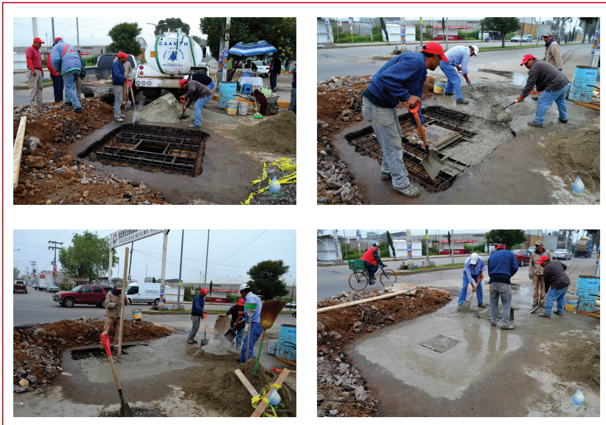
Ilustración 2.5 Colado de losa de caja de válvula por parte del personal de la Comisión de Agua y Alcantarillado del Municipio de Tizayuca, Hidalgo
