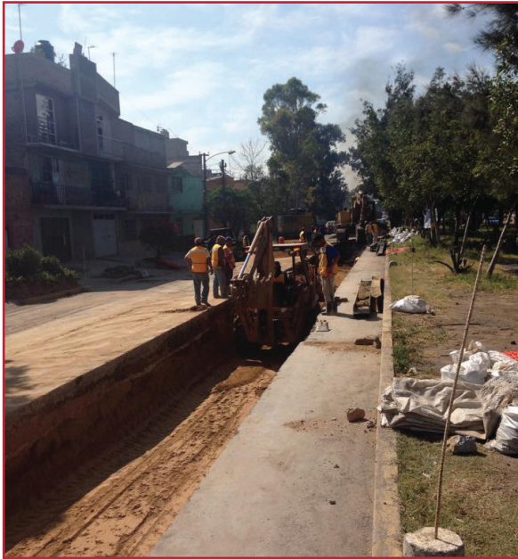
Ilustración 1.52 Relleno de zanjas con material producto de banco por personal de ODAPAS Nezahualcoyotl
