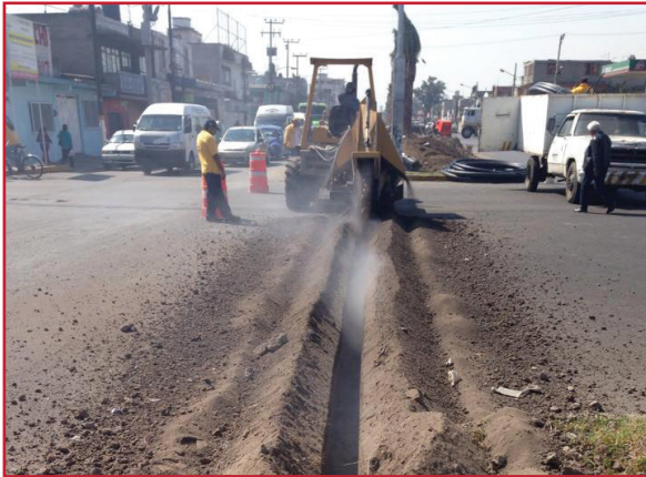
Ilustración 1.50 Corte de Pavimento por personal de ODAPAS Nezahualcoyotl
