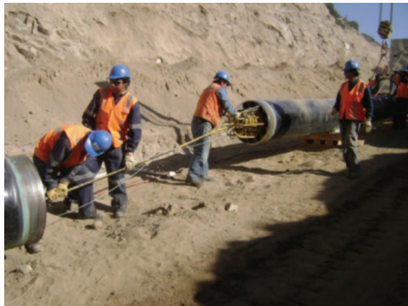
a) Preparación de tubería para instalación, posterior a la elaboración del corte, bisel y limpieza
