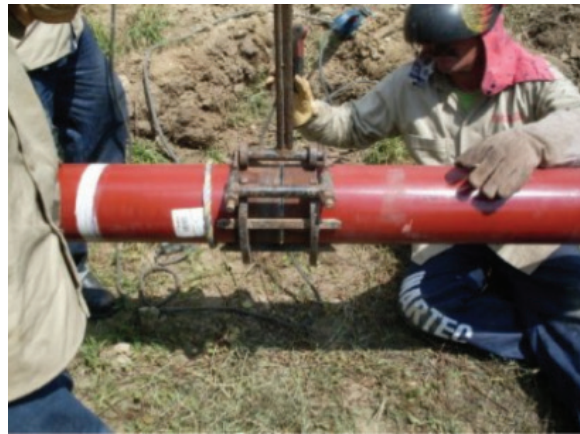
b) Ajuste y alineación del tramo a unir
