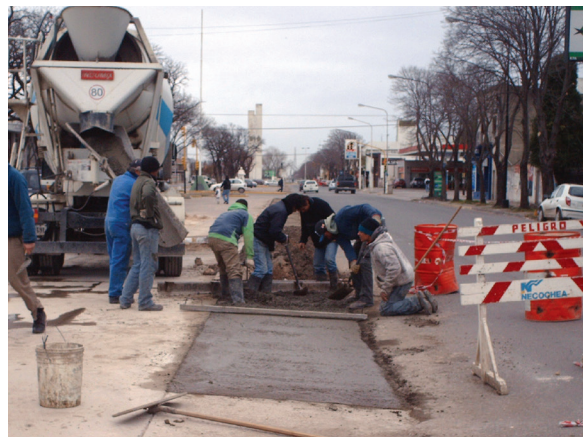
12:30 pm. Restitución de pavimento
