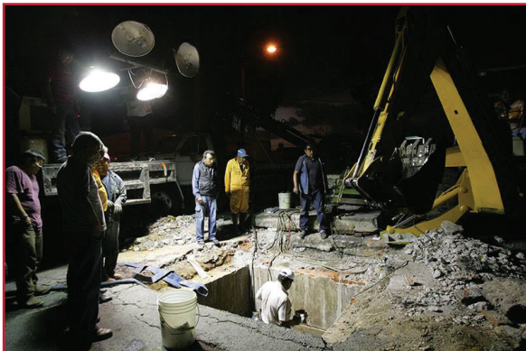
Ilustración 1.53 Restitución de caja de válvulas después de una reparación (ODAPAS, Nezahualcoyotl)
