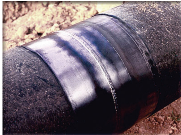
d) Unión soldada mediante anillo de refuerzo
