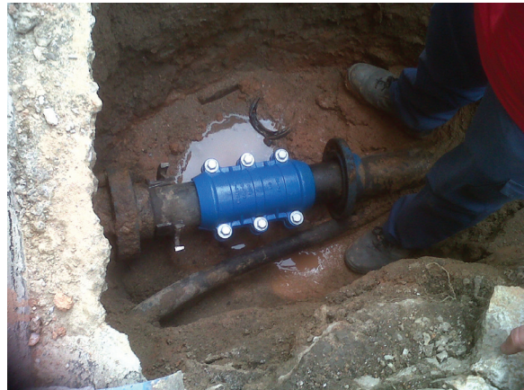
11:00 am. Reparación de la fuga
