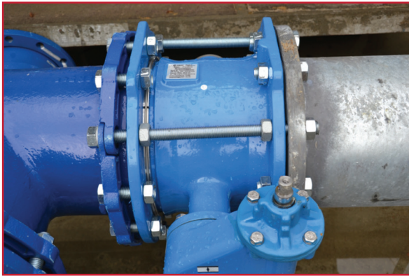
Ilustración 1.28 Unión mediante bridas (miraquehacemos.wordpress.com)
