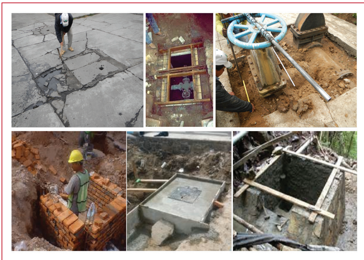
Ilustración 2.7 Restauración y/o remplazo de cajas de válvulas
