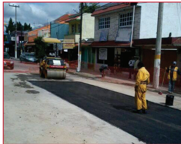
Ilustración 1.54 Restitución de carpeta asfáltica después de una reparación (ODAPAS, Nezahualcoyotl)
