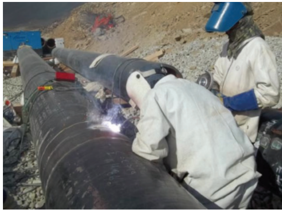
c) Soldadura por personal calificado
