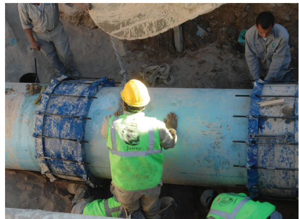
d) Apriete de pieza de reparación (acoplamientos)
