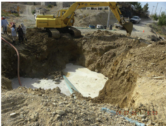
a) Ubicación de la fuga y extracción de agua en la zona de trabajo de la reparación
