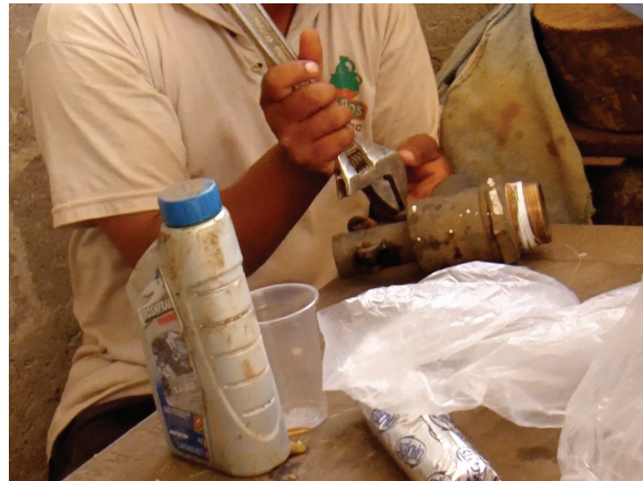
d) Mantenimiento de la válvula
