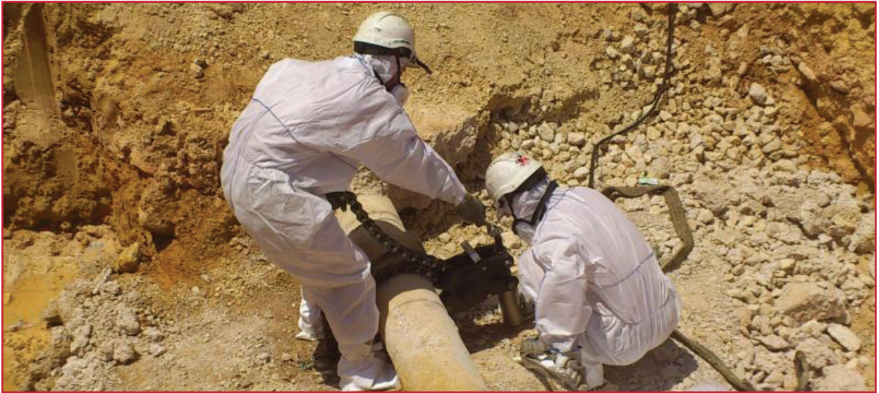
Ilustración 1.11 Equipo de protección personal - corte de tubería de fibrocemento (www.amianto.info)
