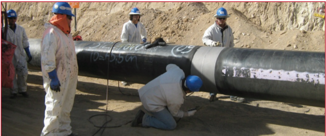
Ilustración 1.27 Aplicación de cintas de polietileno (comunidadpipeline.blogspot.com)
