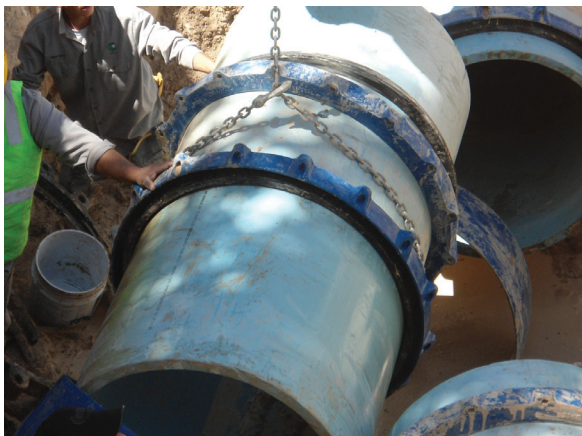
c) Instalación de acoplamientos
