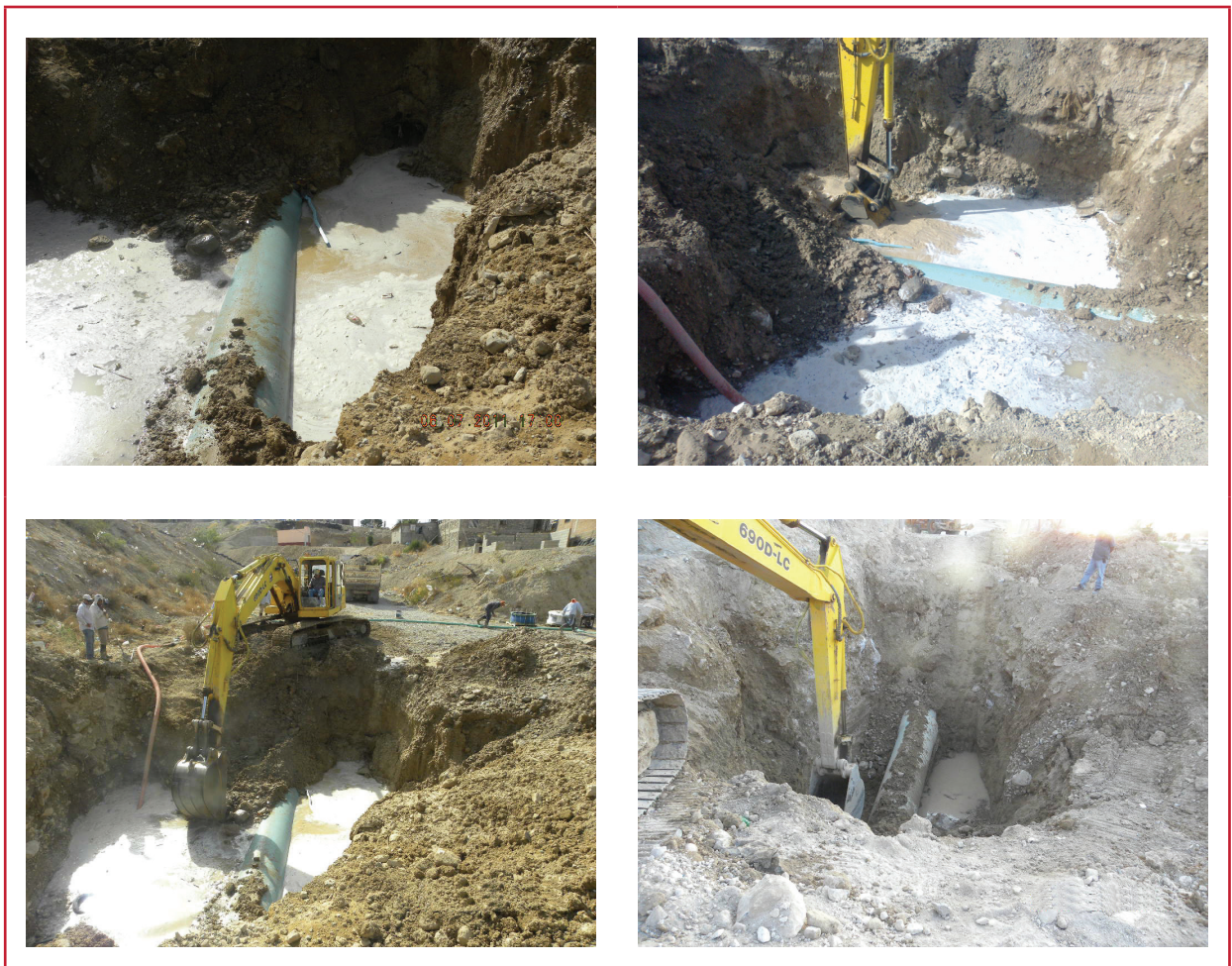
Ilustración 1.6 Localización de fuga en tubería
