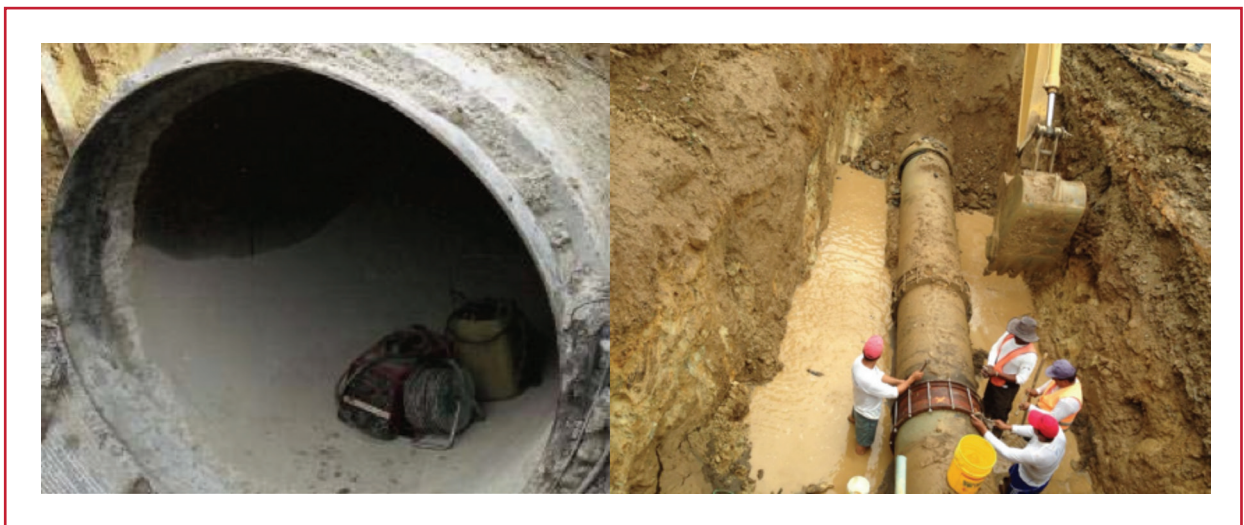
Ilustración 1.8 No olvidar elementos dentro de un tubo y utilizar el equipo de protección necesario (www. ays-eloro.com)
