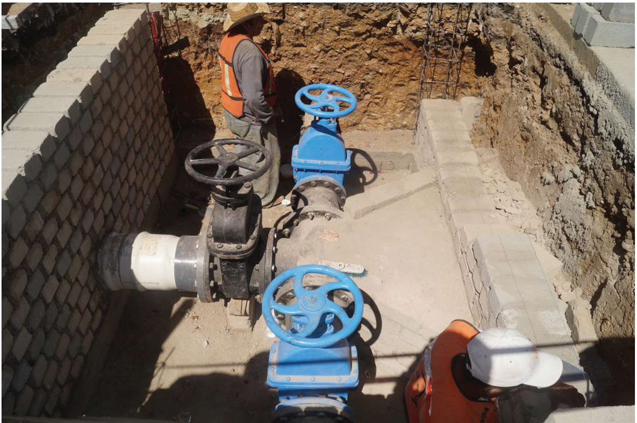
Ilustración 2.4 Construcción de caja de válvula por parte del personal de la ADOSASPACOO
