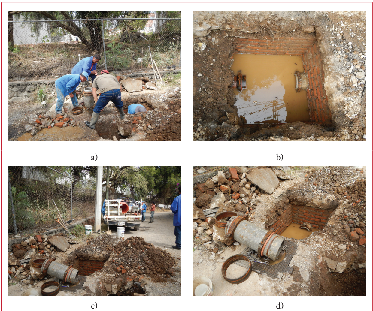
Ilustración 1.47 Reparación de tubería asbesto cemento, realizada por personal del SAPAC
