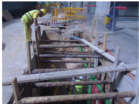
Ilustración 1.9 Ademe en zanja para reparación (sienasl.com)
