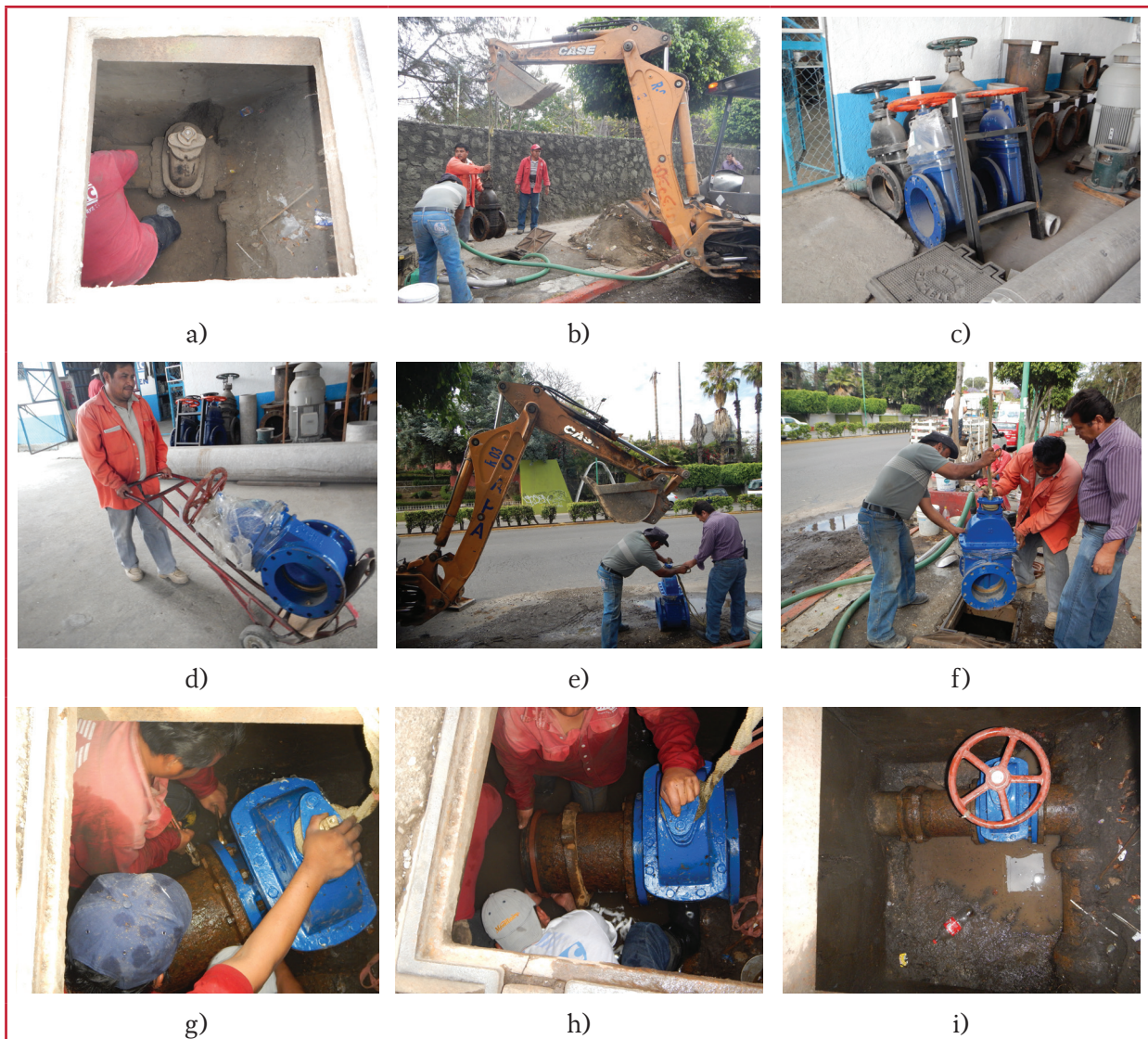
Ilustración 2.3 Trabajos en mantenimiento y remplazo de válvulas de diámetros mayores (SAPAC)
