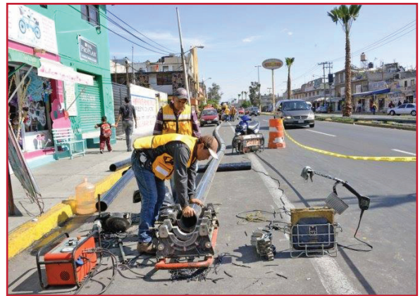
Ilustración 1.51 Preparación de tubería por personal de ODAPAS Nezahualcoyotl
