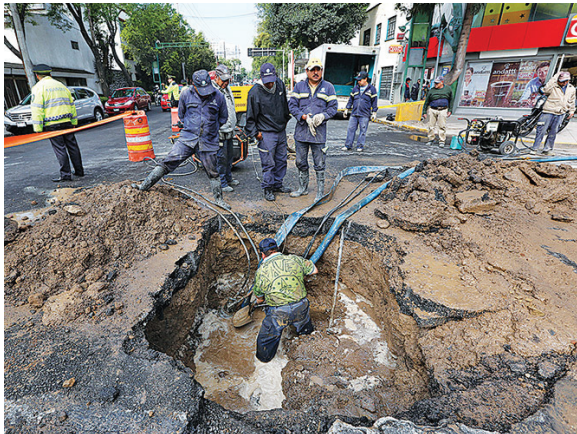
9:00 am. Excavación y detección de la tubería dañada
