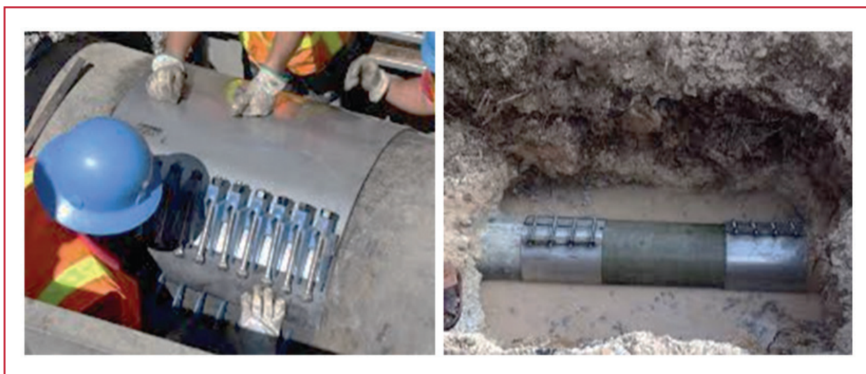
Ilustración 1.13 Reparación de tuberías con una abrazadera de reparación
