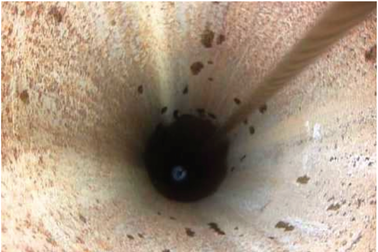
Ilustración 2.4 Ademe de un pozo
