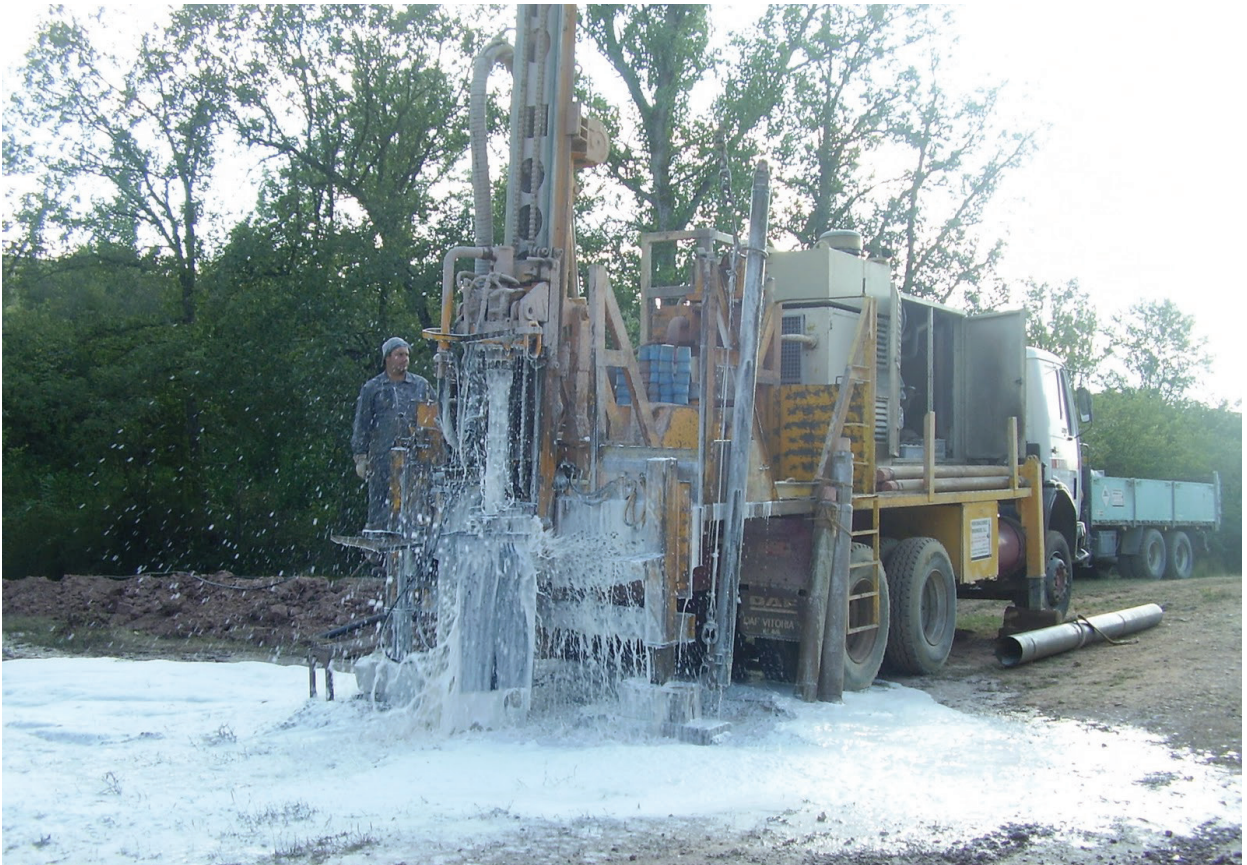
Ilustración 2.3 Construcción de pozos
