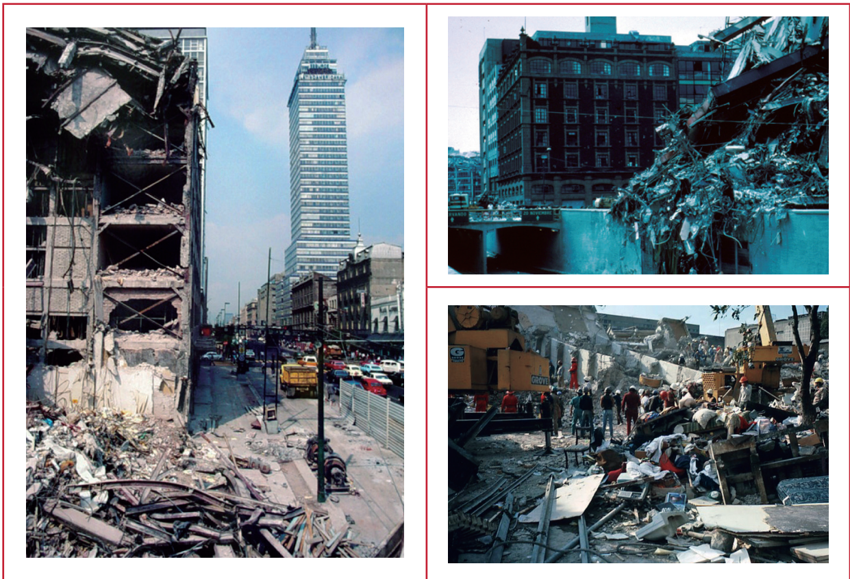
Ilustración 1.1 Daños en la ciudad de México por terremoto en 1985
