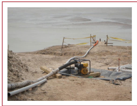
Ilustración 2.12 Obra de toma emergente (yaguaru.wordpress.com)
