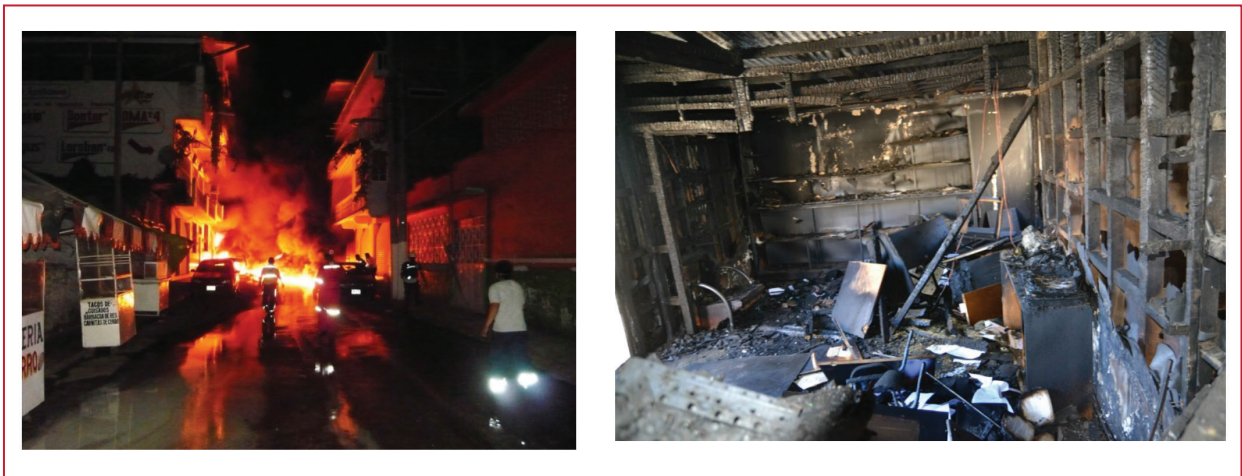
Ilustración 1.20 Incendio de oficinas
