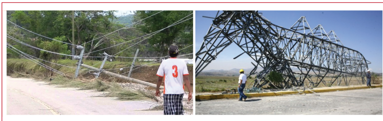
Ilustración 2.5 Daños a líneas de electricidad
