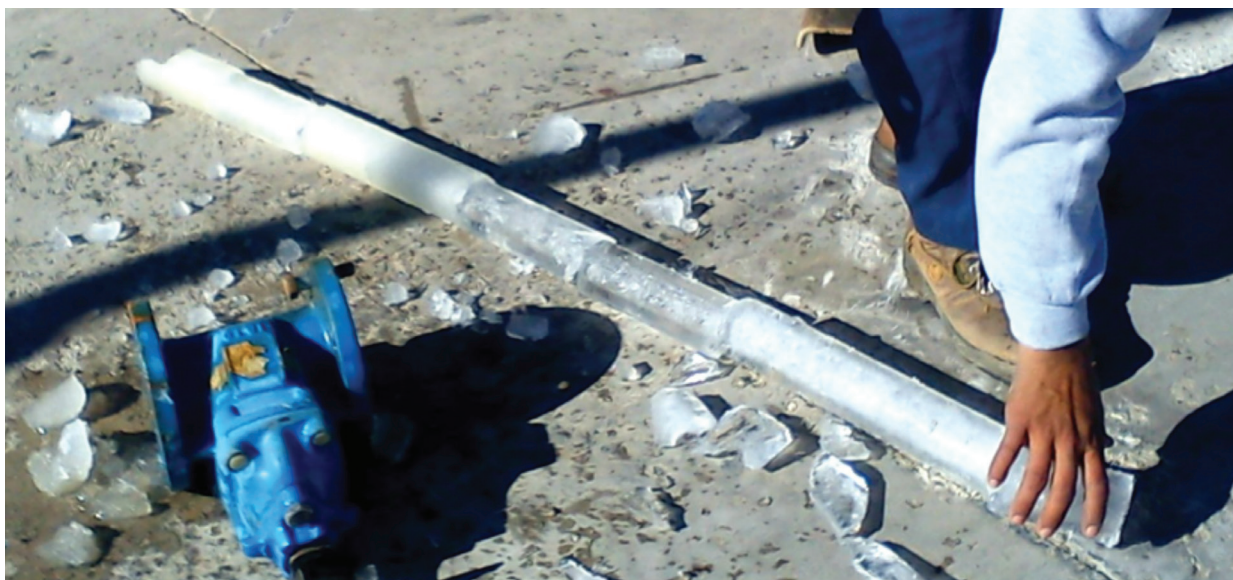
Ilustración 1.18 Congelamiento del aparato medidor de agua en Tecate (codiceenlinea.com)
