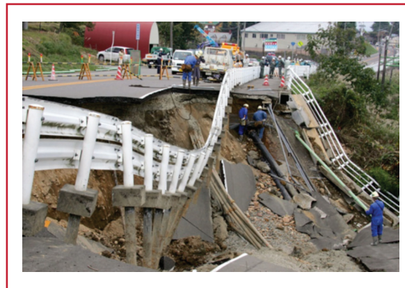
Ilustración 1.5 Daños por licuefacción del suelo (www.taringa.net)
