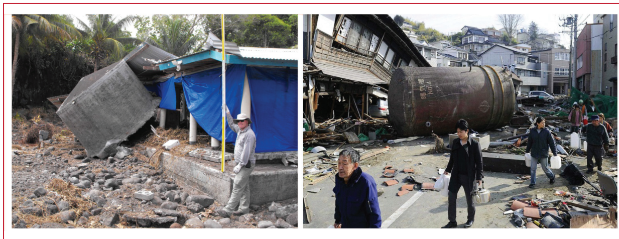
Ilustración 2.3 Daño en tanques por sismos
