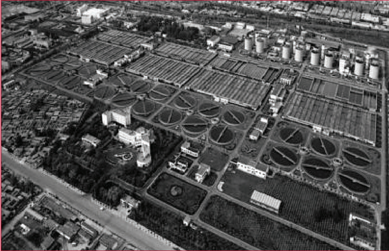
Ilustración 5.47 Vista aérea de la PTAR de Gaobeidian
