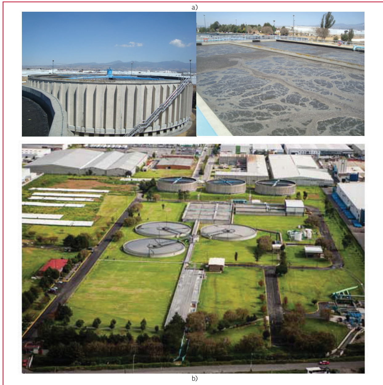
Ilustración 5.49 a) Sistema de filtros rociadores, b) Lodos activados, c) Vista panorámica de la planta de tratamiento Toluca-Norte
