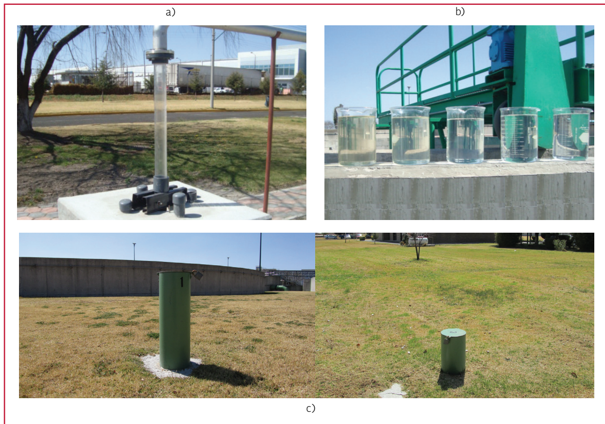
Ilustración 5.53 Recarga al acuífero del Valle de Toluca, a) Pozo de inyección; b) Efluentes de los diferentes procesos de tratamiento; c) Pozos de monitoreo
