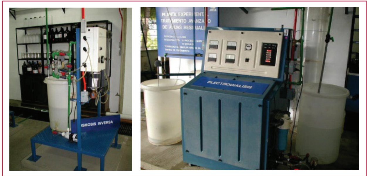
Ilustración 6.3 Instalación experimental para desmineralización: ósmosis inversa, electrodiálisis e intercambio iónico
