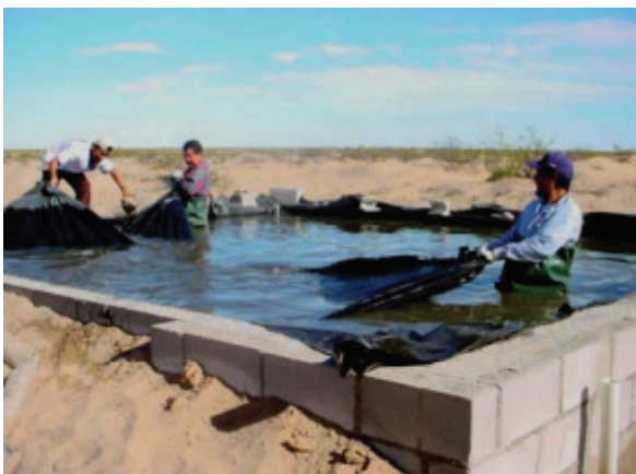
Ilustración 5.55 Tanque piloto para la recarga del acuífero en pruebas preliminares
