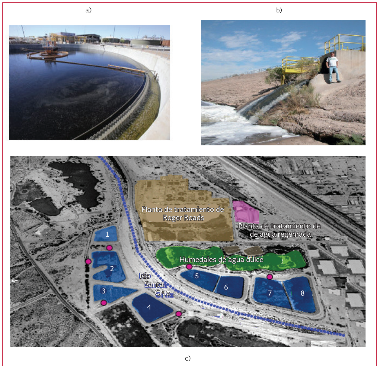
Ilustración 5.38 a) Clarificador secundario, planta de tratamiento Roger Road (Davis, 2013), b) Descarga de la planta de aguas regeneradas al río Santa Cruz, c) Mapa geográfico de las cuencas de infiltración (Water, 2005)
