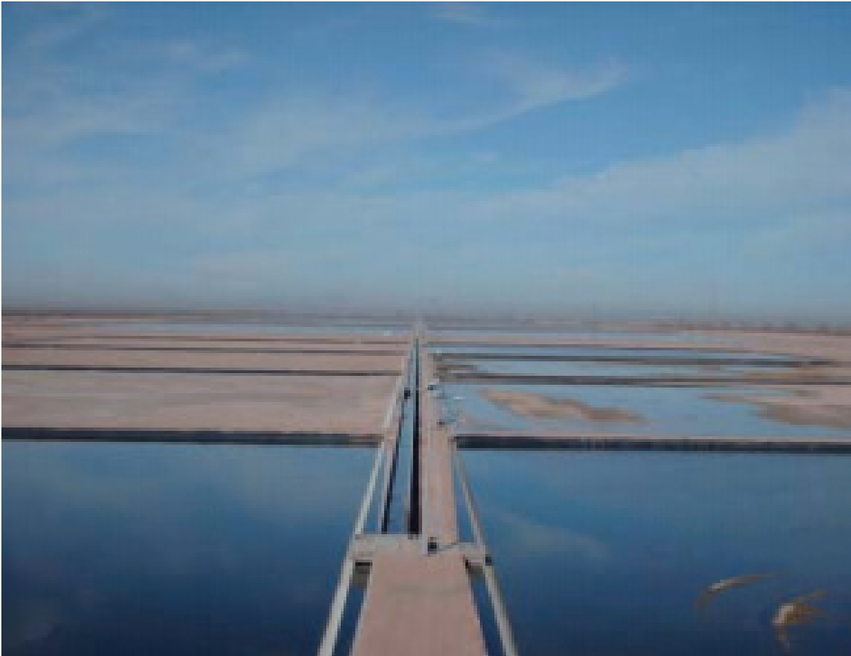
Ilustración 5.56 Lagunas de infiltración de San Luis Río Colorado, vista aérea del tren lagunar
