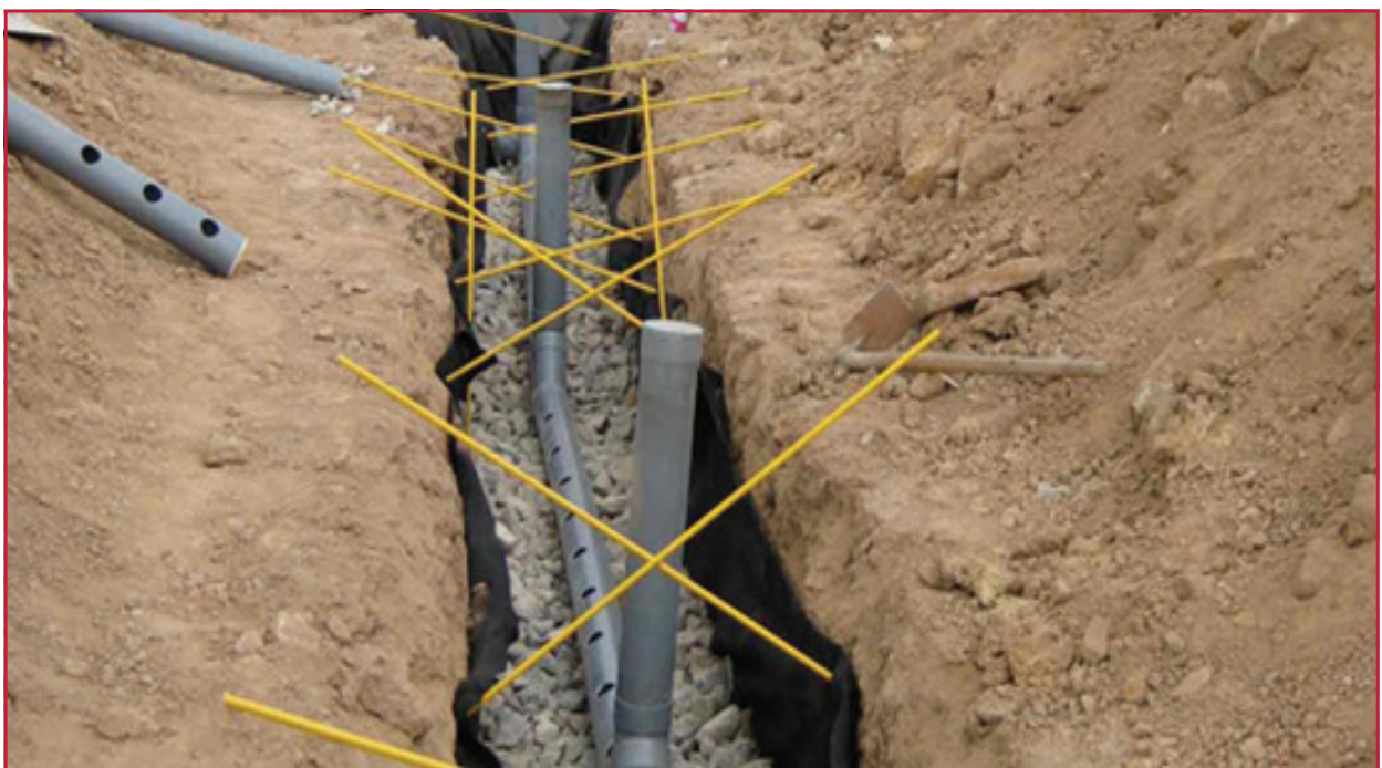
Ilustración 3.2 Tubería con barrenos para zanjas
