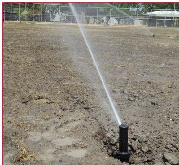
Ilustración 4.2 Aspersores fijos
