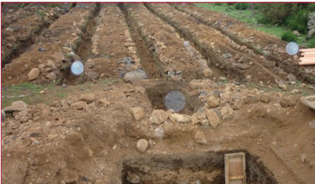
Ilustración 3.3 Ejemplo de zanjas filtrantes
