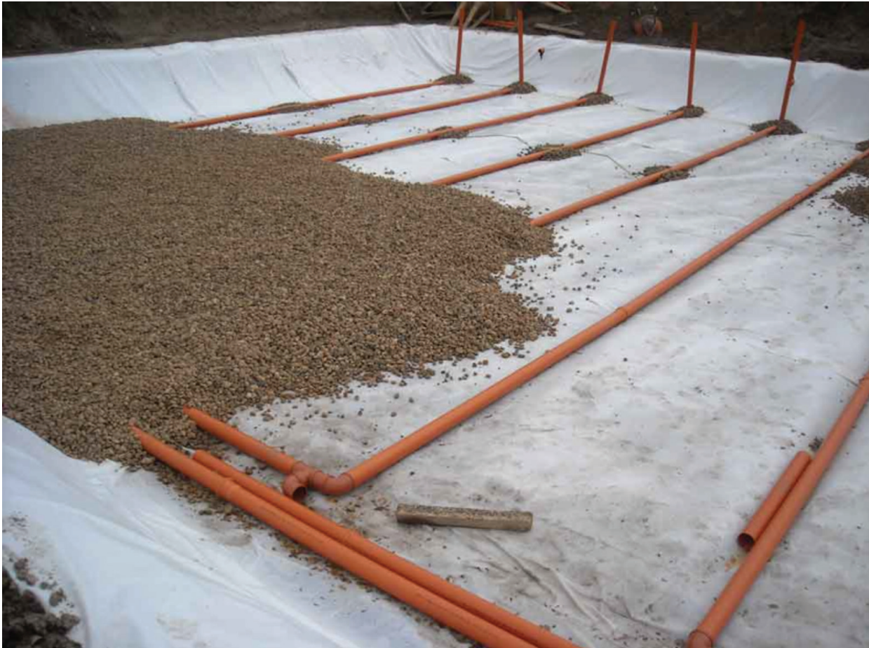
Ilustración 1.2 Instalación de filtro intermitente de arena
