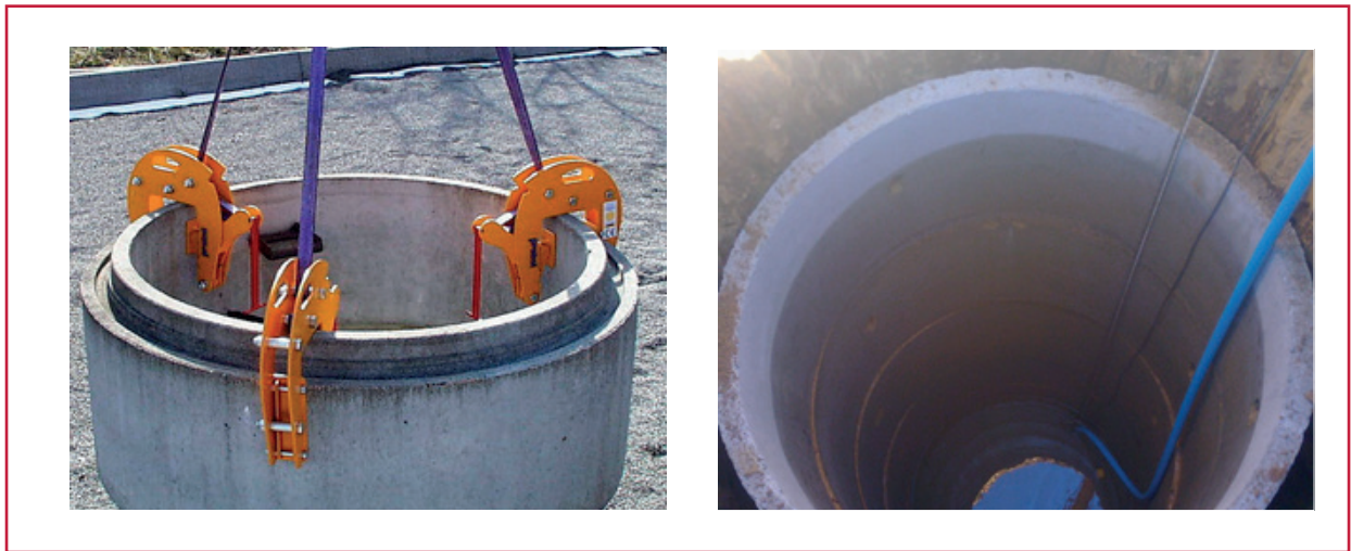
Ilustración 3.10 Anillos de concreto para pozos
