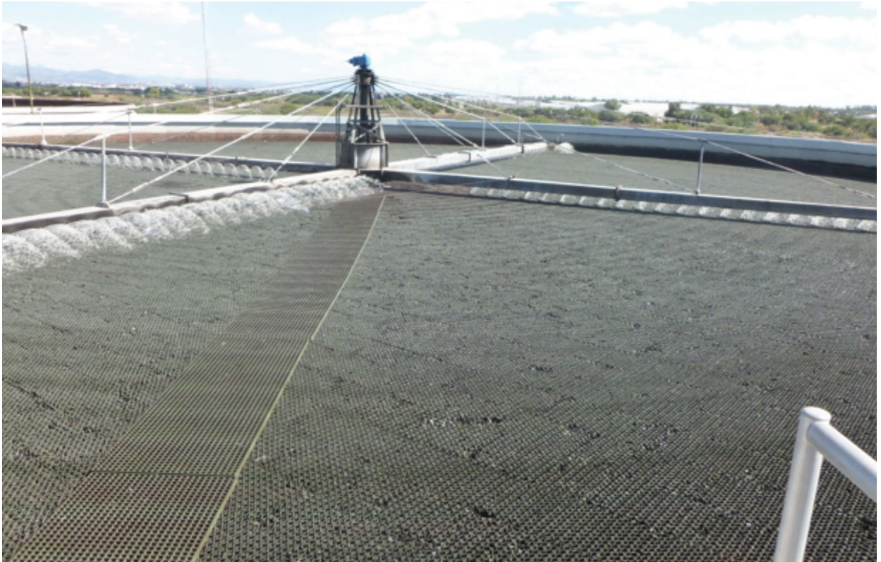
Ilustración 2.7 Medio de soporte de bloques de plástico
