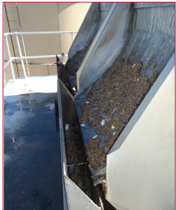
Ilustración 5.27 Tornillo para transportar sólidos de microcriba
