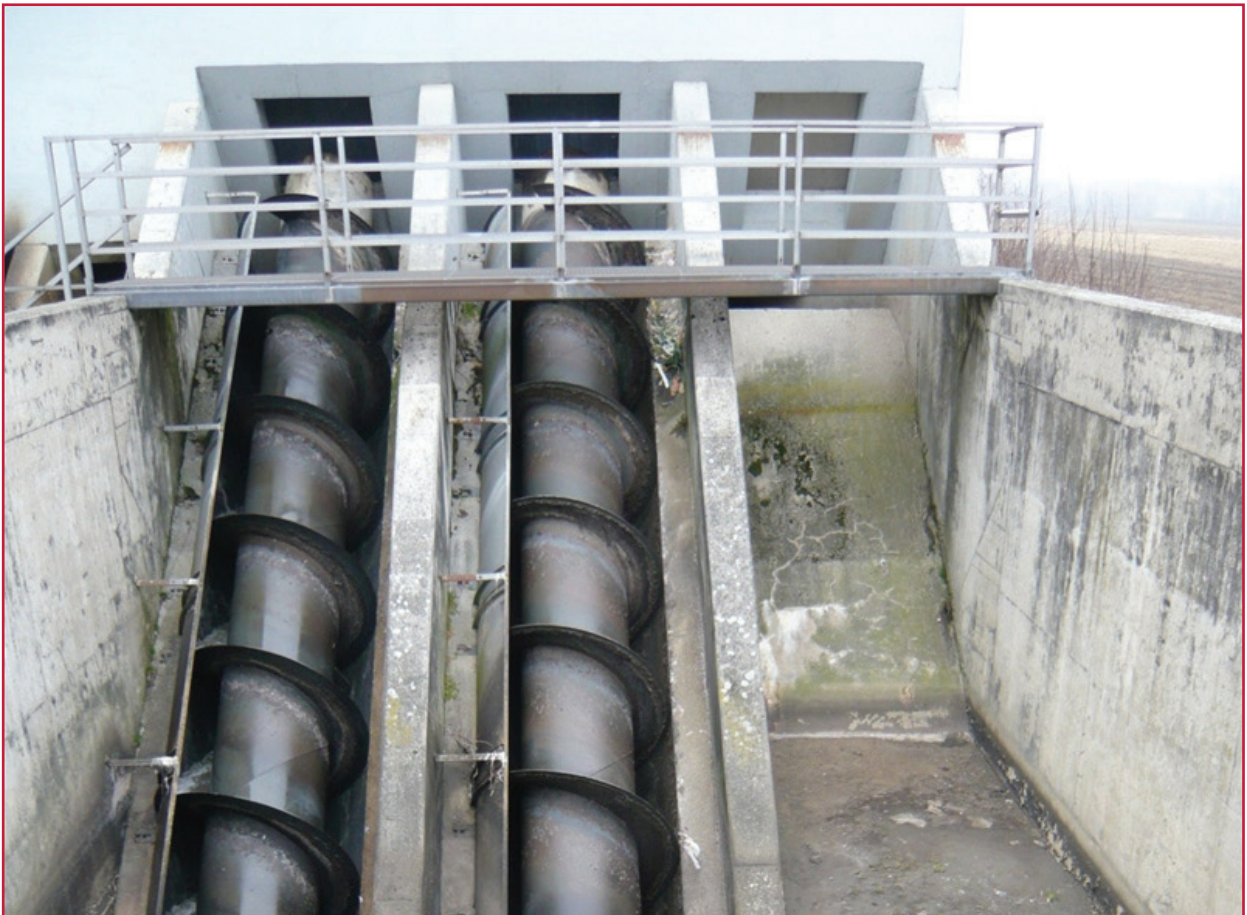
Ilustración 5.9 Bomba de tornillo de Arquímedes
