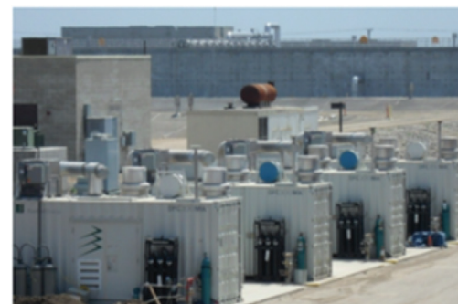
Ilustración 14.12 Celda de combustible
