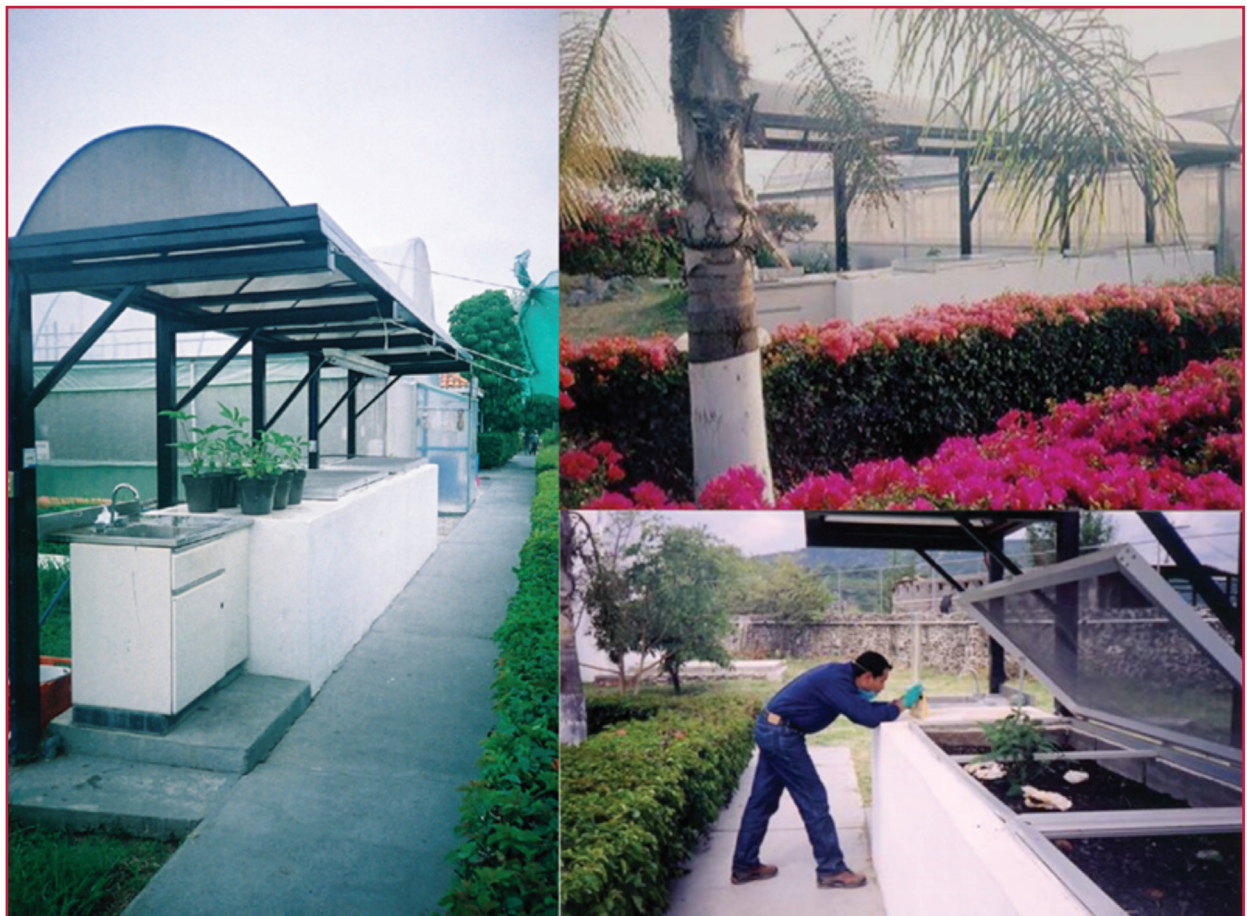
Ilustración 10.31 Sistema de vermicomposteo IMTA para una planta de tratamiento de <1 \text{ L s}^{-1}
