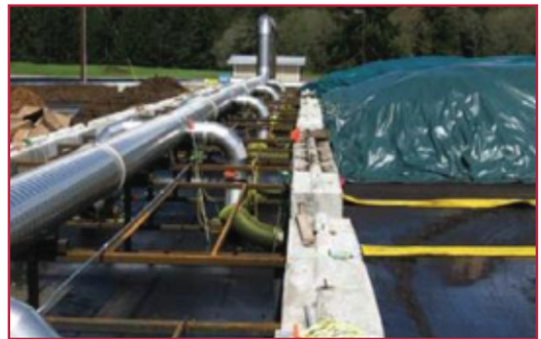
Ilustración 9.12 Canal perforado para la inyección de aire
