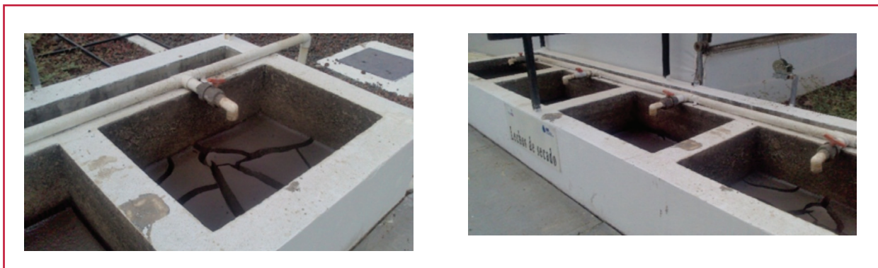
Ilustración 10.14 Lodos adecuados para vermicomposteo provenientes de lechos de secado
