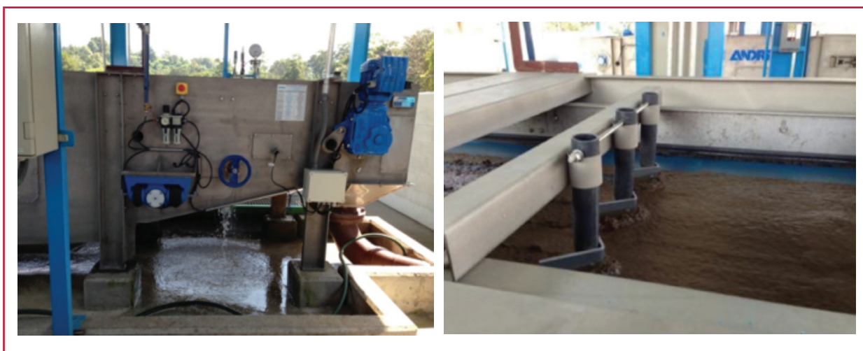
Ilustración 6.14 Equipo para espesamiento por gravedad en banda
