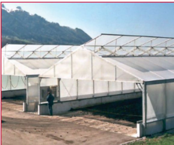
Ilustración 12.26 Invernadero con sistema de ventilación abatible, (WENDEWOLF, 2013)
