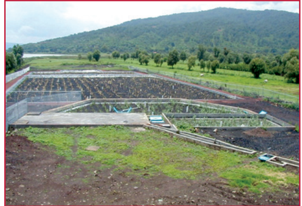
Ilustración 3.3 Humedal artificial de flujo subsuperficial subterráneo
