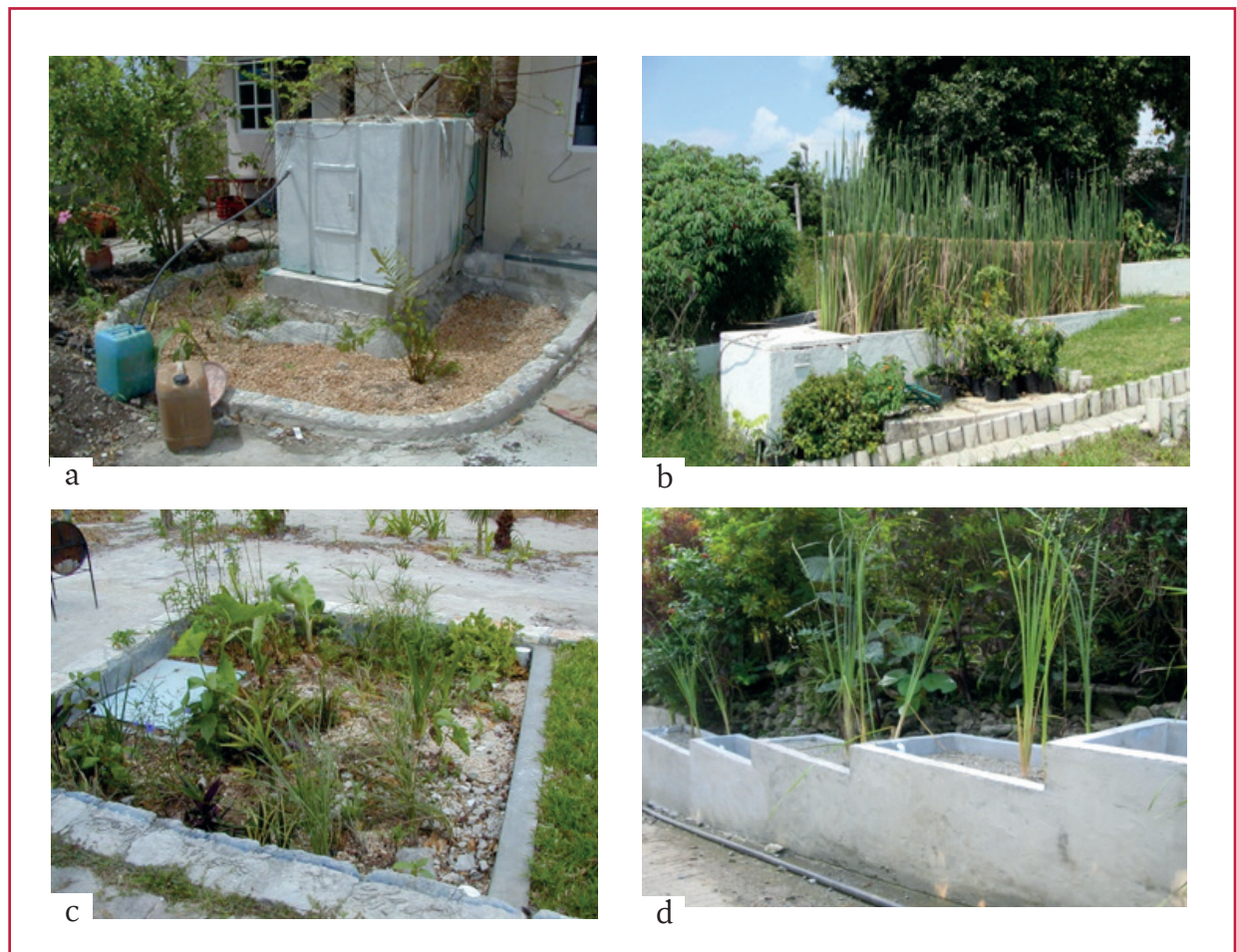
Ilustración 3.2 Humedal artificial tipo familiar
