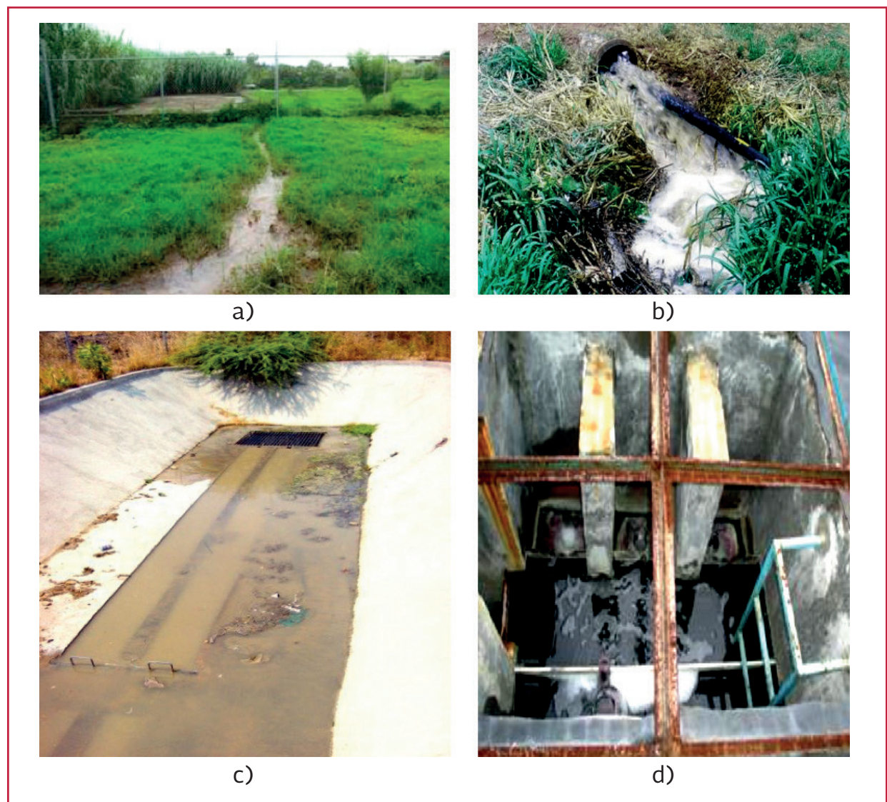
Ilustración A.5 Tendencia de los lechos a secarse. a) Taponamiento o roturas del colector, antes de llegar al sistema, b) Ordeña del agua de los lechos, c) Azolve del pretratamiento, d) Corrosión de estructuras de distribución de caudal
