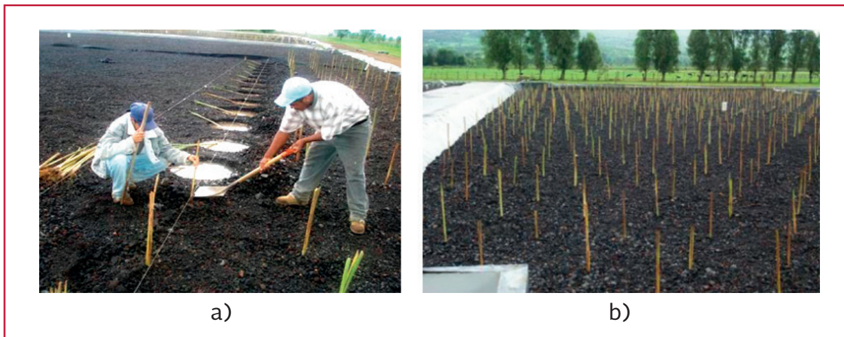
Ilustración 2.36 Plantado de especies vegetales. a) siembra de especies, b) humedal terminado de sembrar
