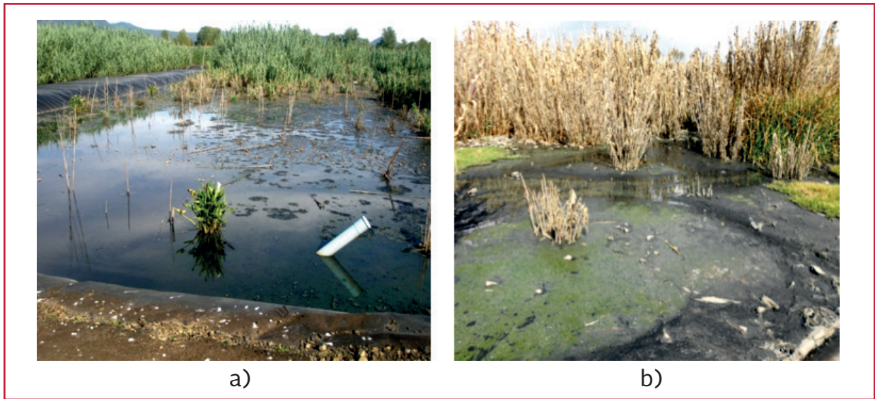
Ilustración 2.12 Problemas de azolve en humedales artificiales (Fuente b: Conagua, 2014)
