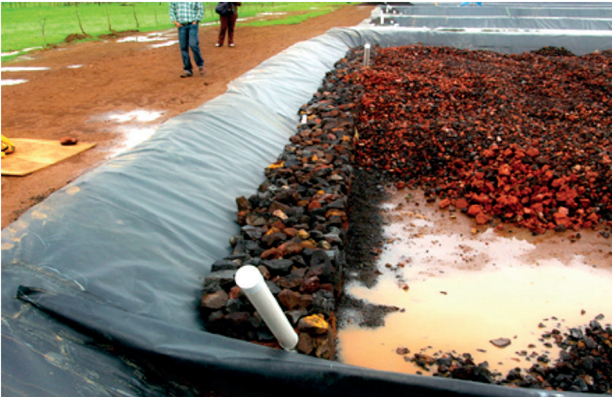
Ilustración 2.34 Colocación del cabezal de distribución de caudal
