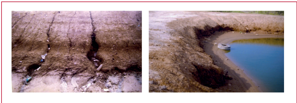
Ilustración 2.10 Bordos construidos con materiales inadecuados
