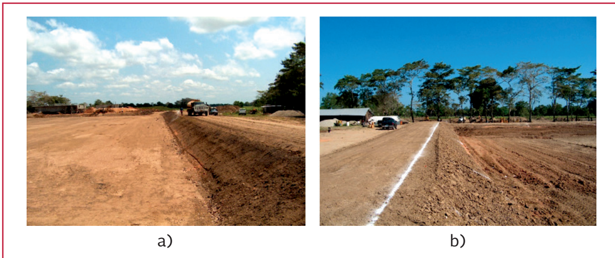
Ilustración 2.16 Construcción de taludes mediante arcilla
