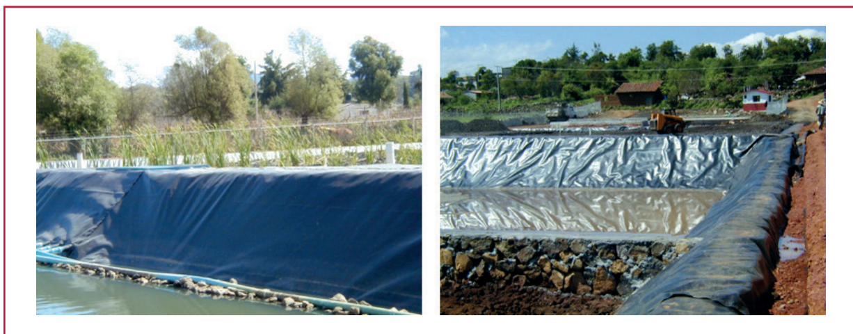
Ilustración 2.18 Construcción de bordos mediante geomembrana anclada
