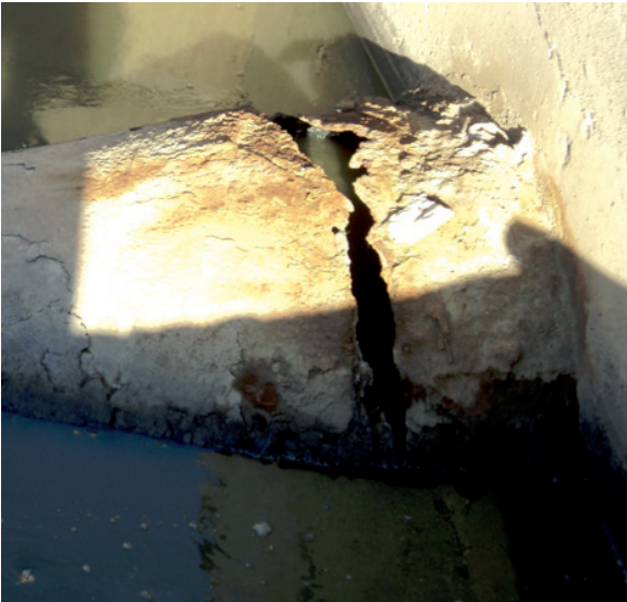
Ilustración 2.14 Tubería deteriorada
