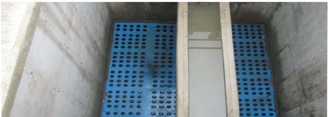
Ilustración 6.12 Falso fondo formado a base de losas prefabricadas con boquillas ranuradas de plástico
