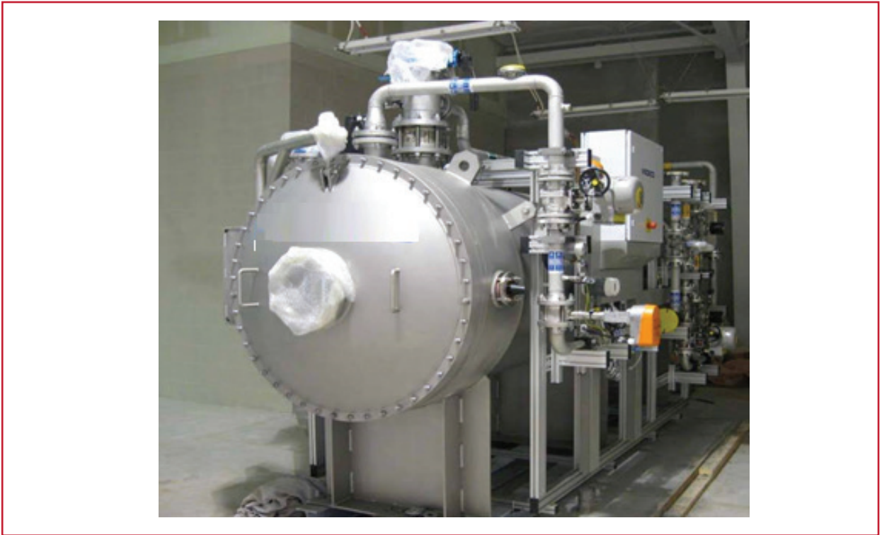
Ilustración 6.5 Cámara de contacto en tres etapas con difusor de burbujas
