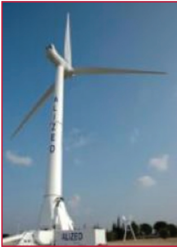
Ilustración 2.24 Aerogenerador tipo Tripala
