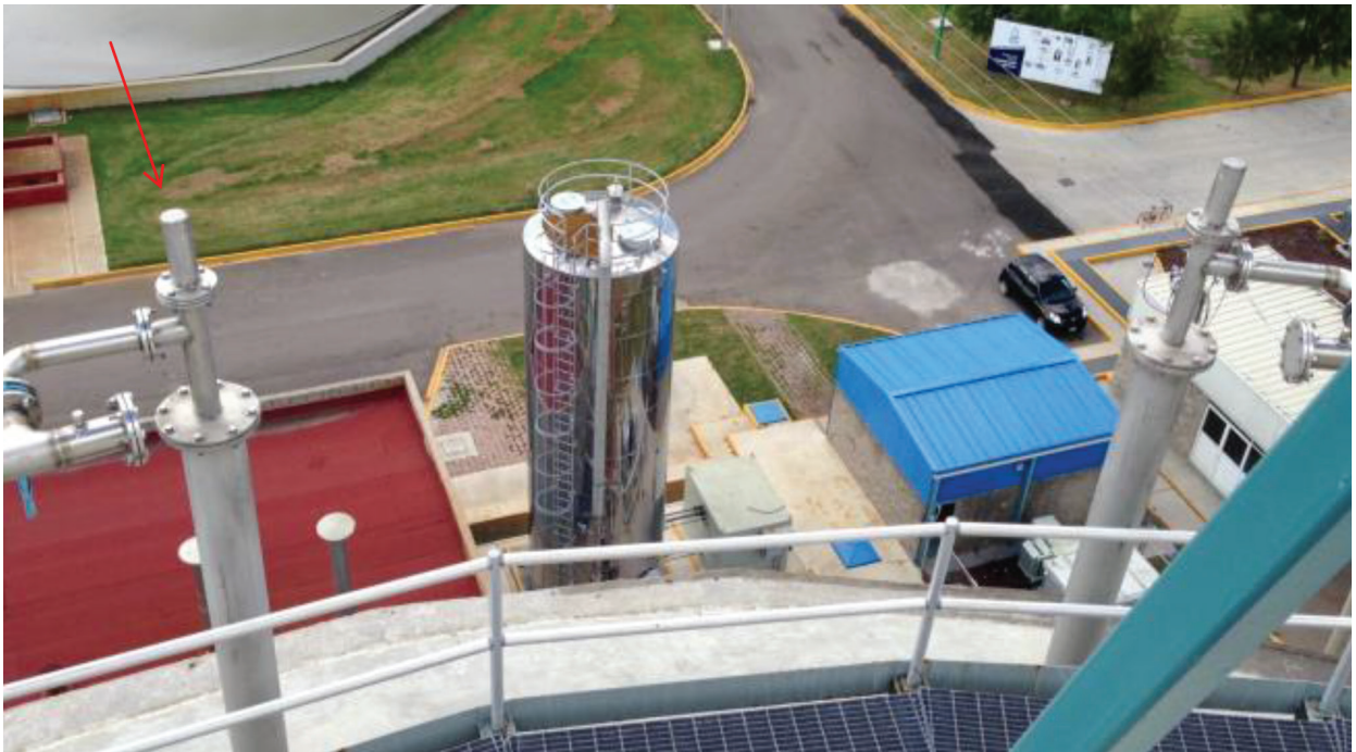
Ilustración 3.17 Lanzas para el mezclado del biogás y torre biológica para eliminación de H 2 S
