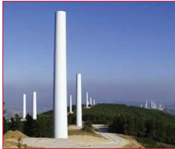
Ilustración 2.30 Aerogenerador tipo torre tubular
