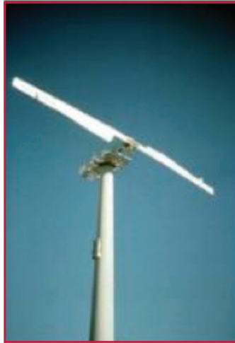
Ilustración 2.25 Aerogenerador tipo Bipala
