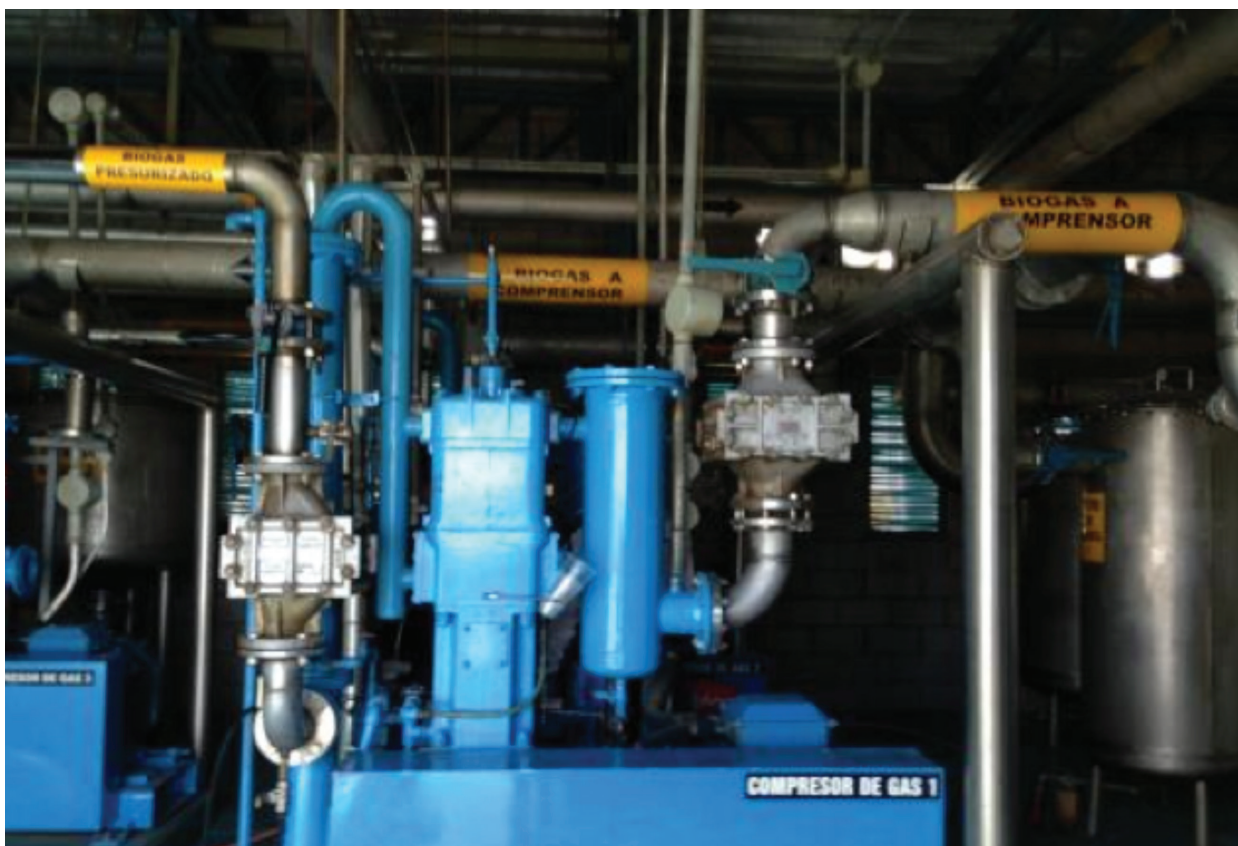
Ilustración 3.19 Sistema de compresión de biogás
