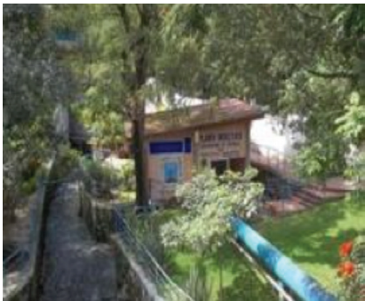
Ilustración 1.17 Casa de máquinas
