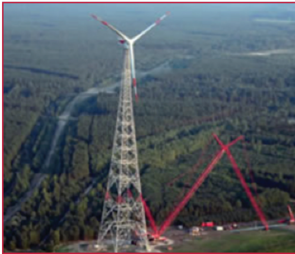
Ilustración 2.29 Aerogenerador tipo torre de celosía
