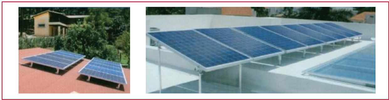
Ilustración 4.37 Instalación en techo
