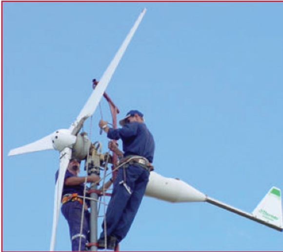
Ilustración 2.40 Instalación de aerogenerador.
