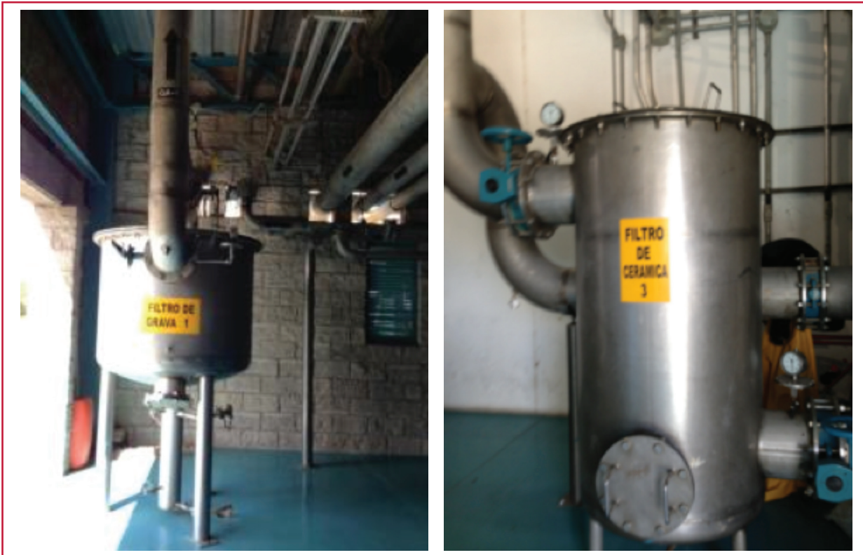
Ilustración 3.19 Sistema de compresión de biogás
