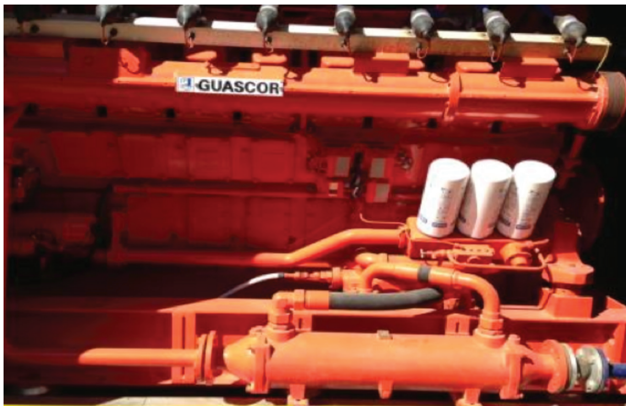
Ilustración 3.23 Motor de cogeneración
