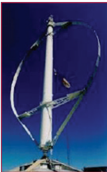
Ilustración 2.21 Aerogenerador tipo Darrieus
