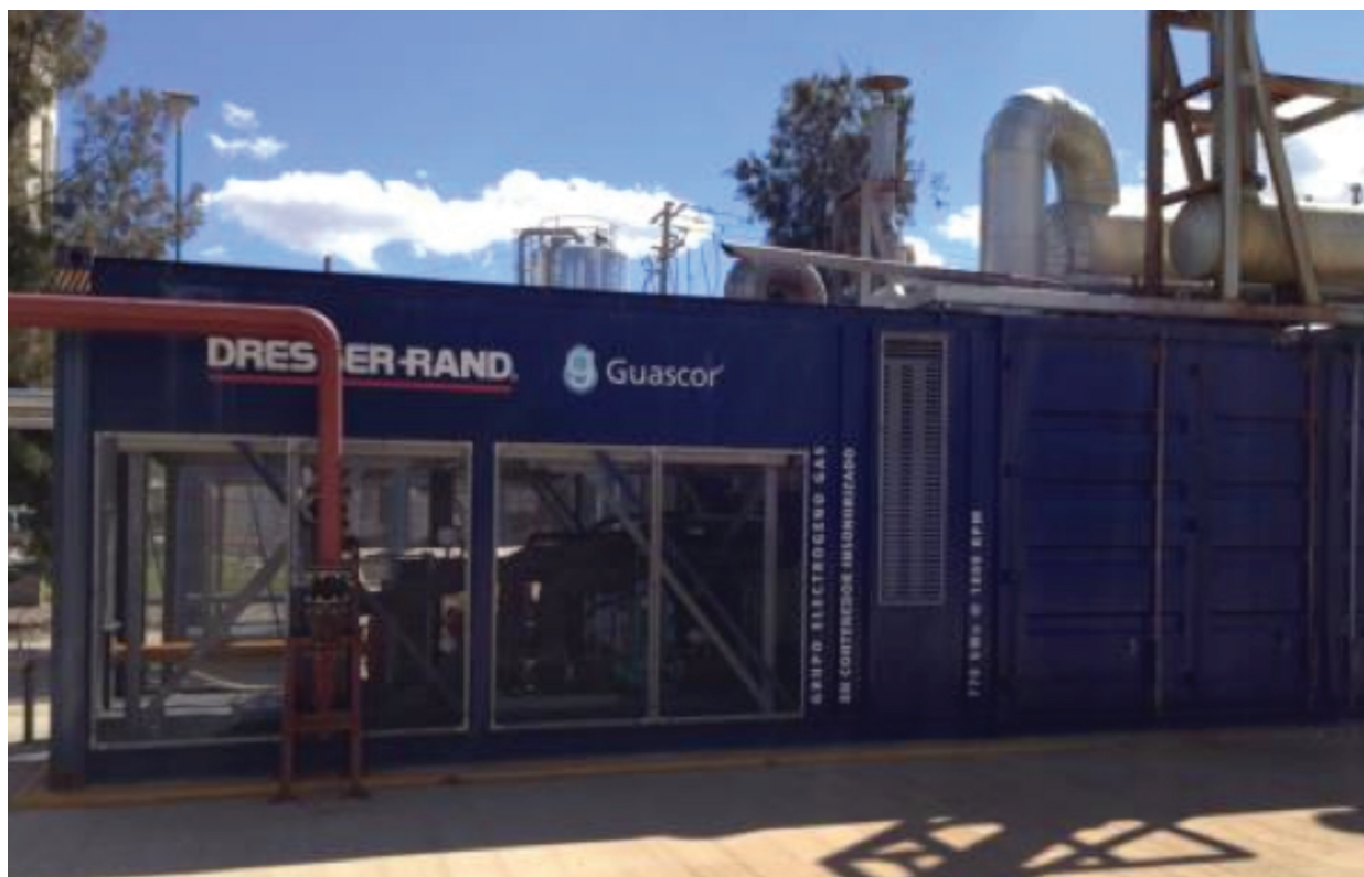
Ilustración 3.23 Motor de cogeneración
