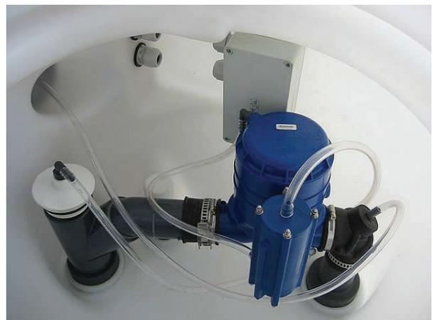
c) Válvula de vacío (<http://www.roevac.com/>)
