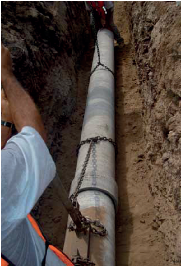
Ilustración 5.16 Encampanado dentro de la zanja
