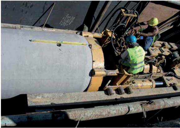
Ilustración 5.61 Hincado de tubería en obra
