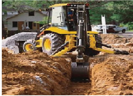
b) Excavación a máquina
