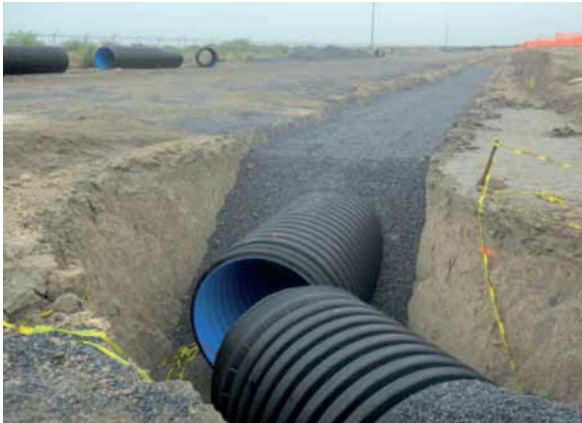
Ilustración 5.90 Acostillado y relleno de grava para recubrimiento mínimo
