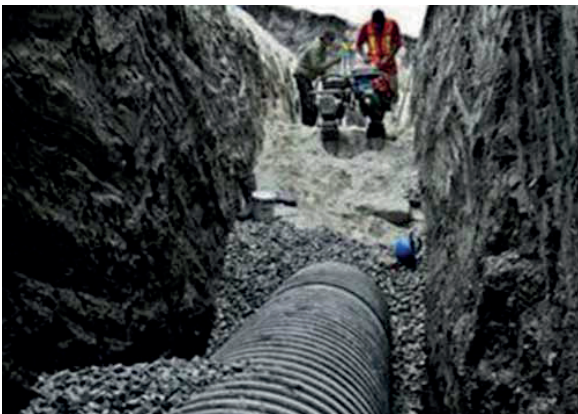
Ilustración 5.89 Acostillado de alta resistencia con grava y relleno final de arena
