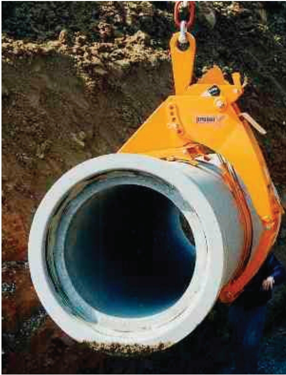
Ilustración 5.54 Accesorio (pinza) para maniobra (levantar) de tubería de diámetros mayores
