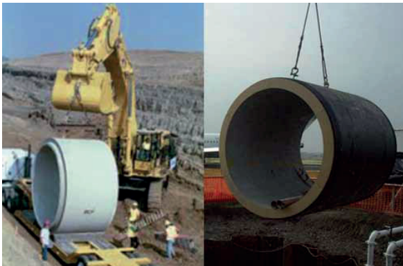
Ilustración 5.55 Ejemplos de levante de tubería
