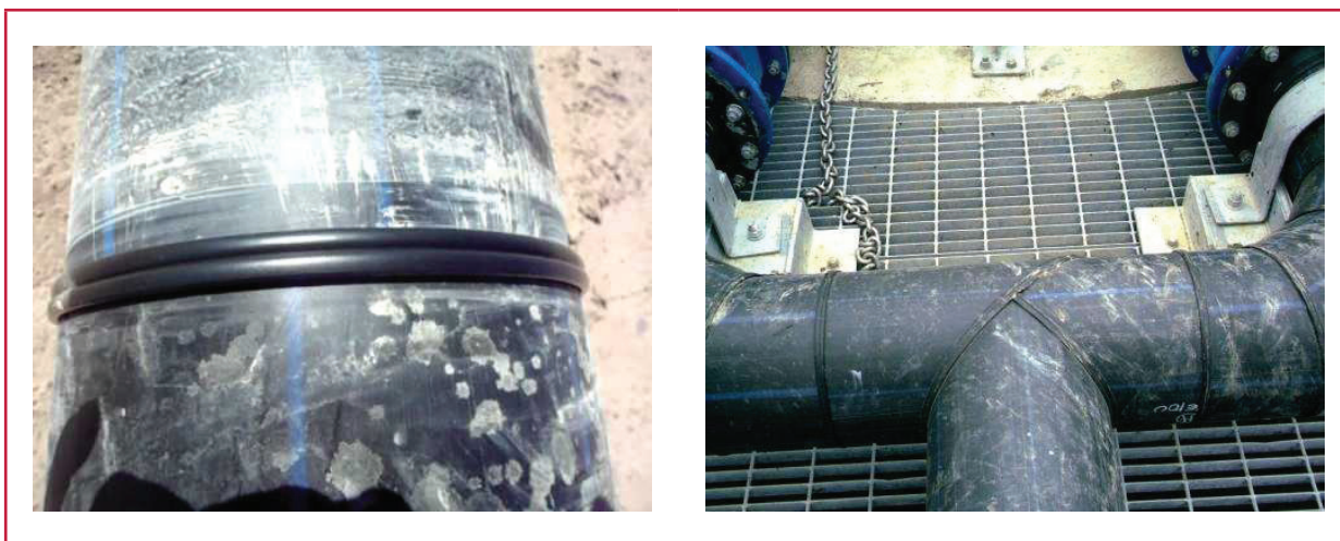
Ilustración 2.11 Tipos de uniones en tuberías de polietileno
