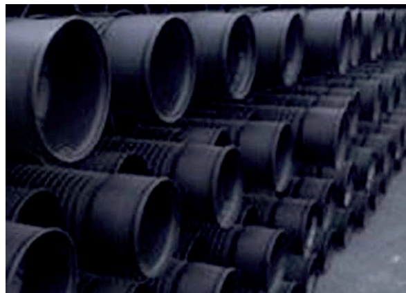
Ilustración 5.83 Apilado alternando la campana
