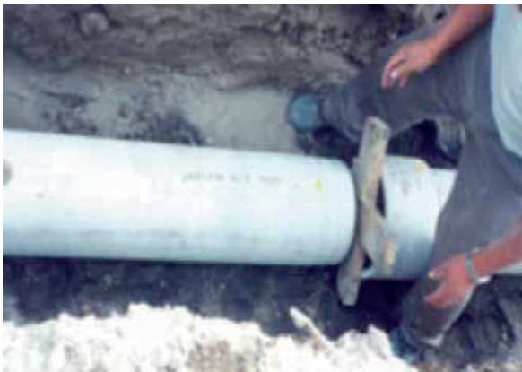
Ilustración 5.21 Colocación de cruceta de madera para enchufe de cople a tubo
