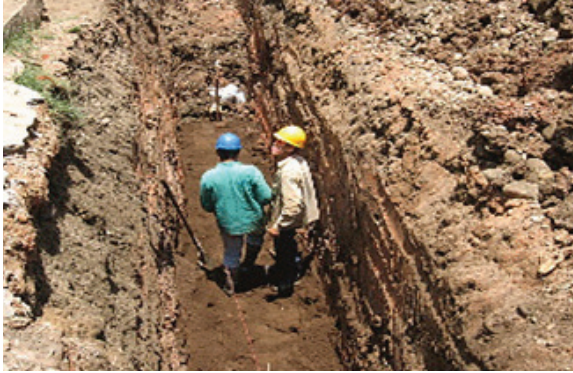
a) Excavación a mano
