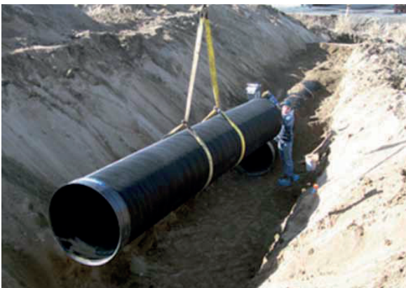
Ilustración 5.82 Descarga correcta
