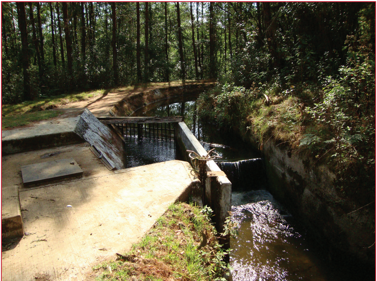
Ilustración 2.3 Ejemplo de una captación superficial
