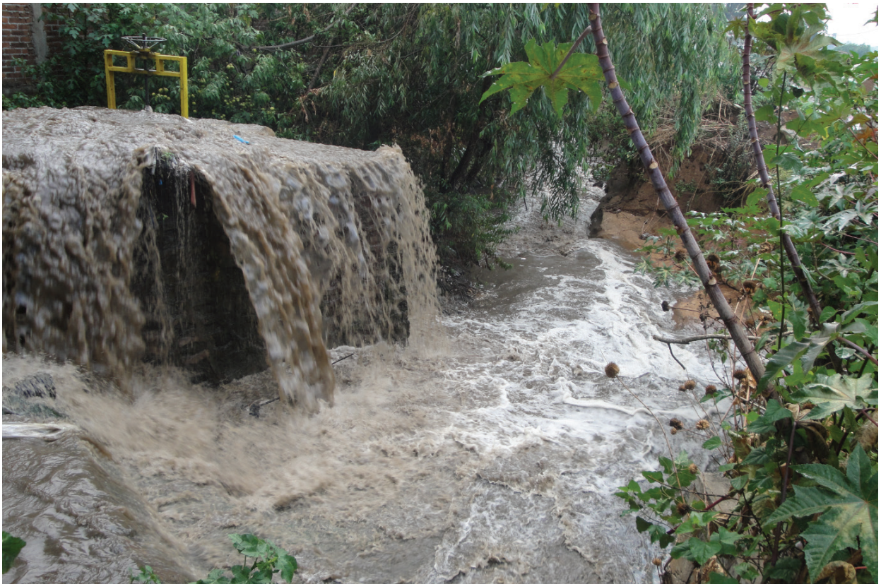
Ilustración 2.20 Contaminación de afluente por falla en la red de alcantarillado sanitario
