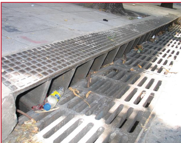
Ilustración 2.15 Boca de tormenta
