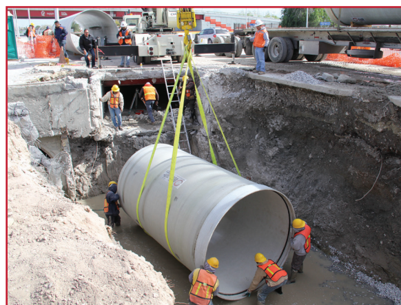
Ilustración 2.12 Tubería para drenaje pluvial
