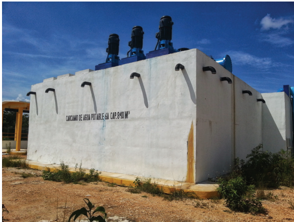
Ilustración 2.8 Tanque superficial de concreto
