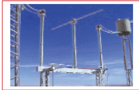
Ilustración 2.28 Cuchilla de doble apertura lateral central
