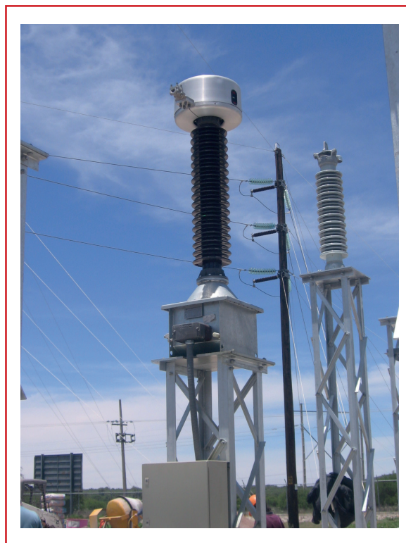
Ilustración 2.35 Transformador de instrumentos TC
