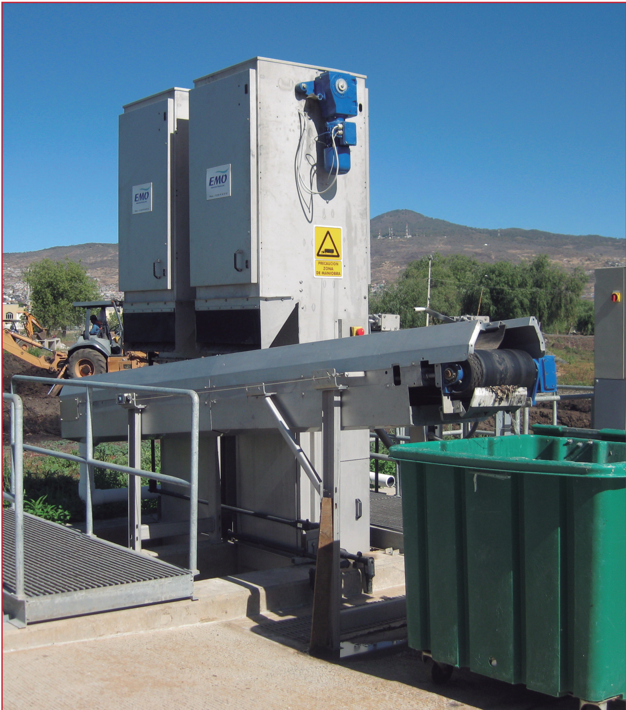
Ilustración 7.16 Limpieza de rejilla
