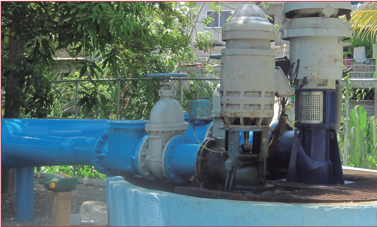
Ilustración 8.30 Válvula de compuerta con bonete atornillado y vástago saliente
