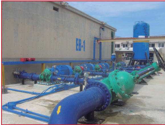
Ilustración 4.13 Bomba en paralelo
