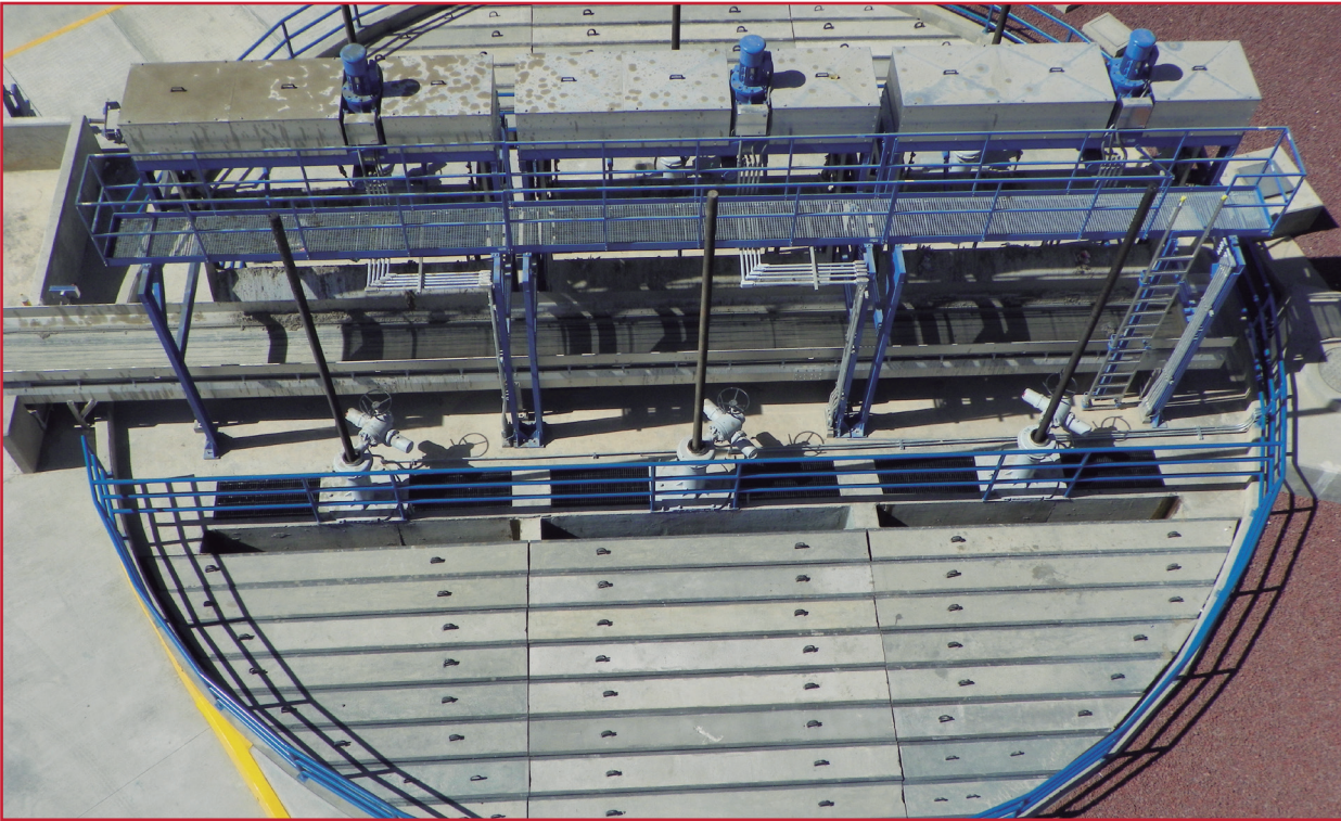
Ilustración 6.1 Ejemplo de cárcamo de bombeo
