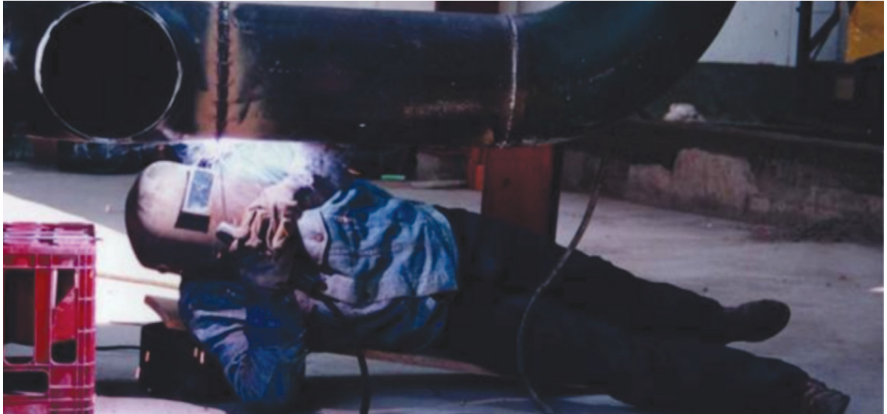
Ilustración 5.7 Soldadura en tubería
