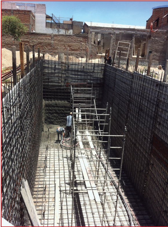
Ilustración 6.2 Construcción de cárcamo rectangular
