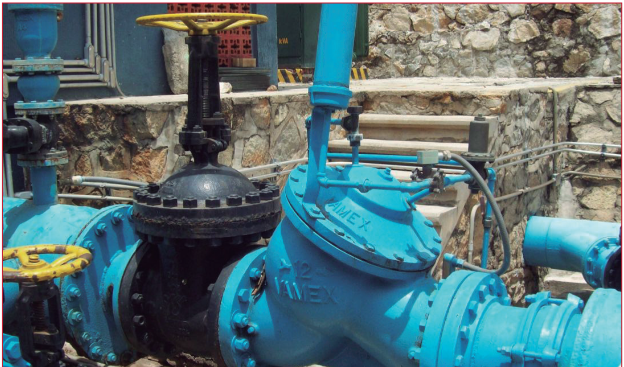
Ilustración 8.29 Válvula de seccionamiento y estrangulación
