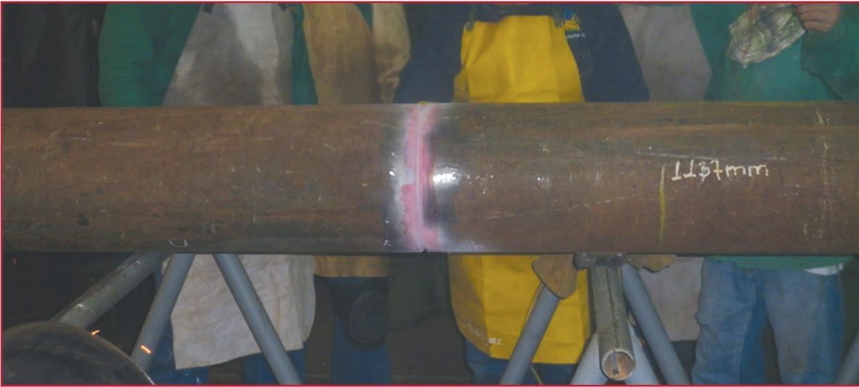
Ilustración 5.15 Soldadura en unión
