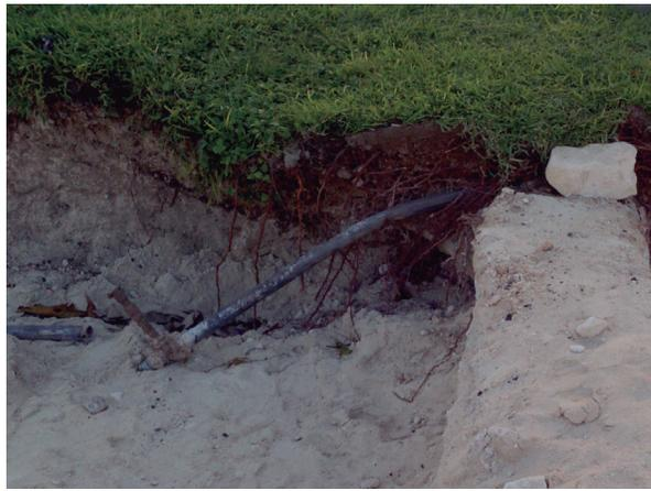
a) Ruptura de toma domiciliaria por excavación
