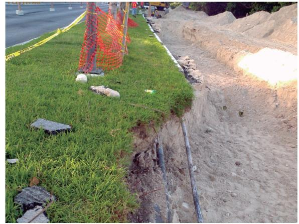
b) Ruptura de guarnición durante excavación
