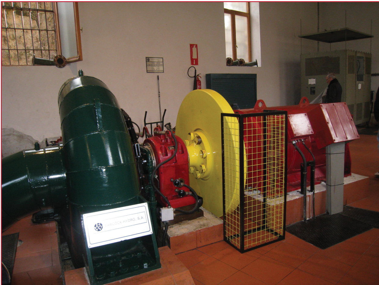
Ilustración 2.14 Equipo de bombeo con volante de inercia ( http://www.eoi.es/blogs/merme/page/15/ )
