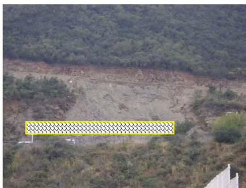
Fotografía 7.5.7.2.7.2. Líneas de gaviones en la base del talud para retener posibles finos.
