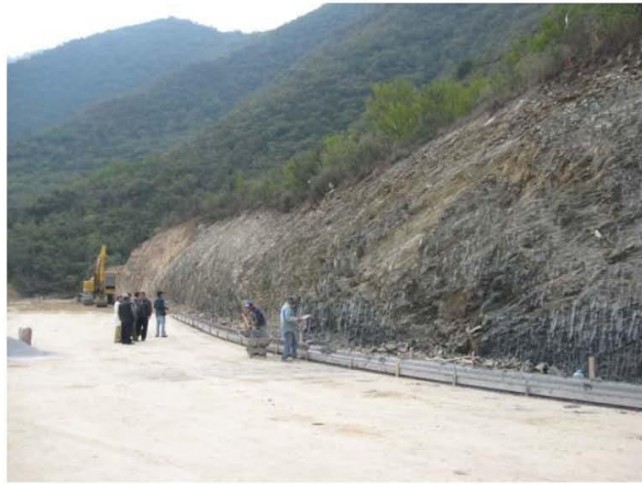
Fotografía 7.5.7.2.8d. Vista de talud.
