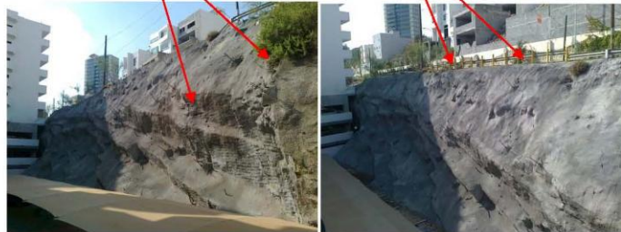
Fotografías 7.3c. Vista del edificio Santa Fe I, antes y después del siniestro septiembre 24 de 2010.
