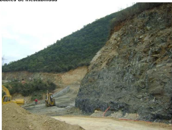
Fotografía 7.5.7.2.5.1. Fracturamiento en el macizo rocoso.
