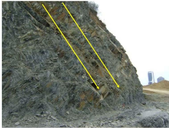
Fotografía 7.5.7.2.5.2. Planos de debilidad, en este caso corresponden a estratificación.
