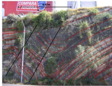
Fotografía 3.3.3. Zona de plegamientos sobre el corte en la avenida San Francisco, al fondo se observan los edificios de La Diana.
