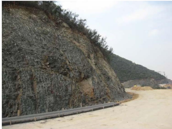
Fotografía 7.5.7.2.8b. Vista de talud.
