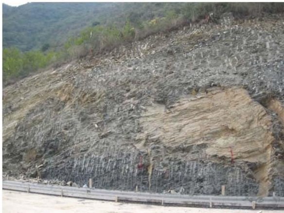
Fotografía 7.5.7.2.8c. Vista de talud.
