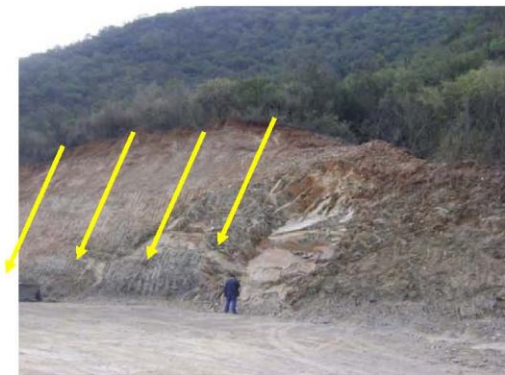
Fotografía 7.5.4c. En esta zona existe un grado intenso de fracturamiento, el cual no tiene un patrón definido hacia una dirección.
