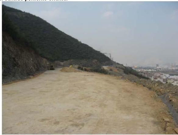
Fotografía 7.5.7.2.8. Vista de talud.
