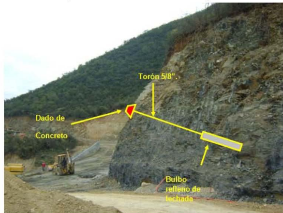
Fotografía 7.5.7.2.5.2a. Estabilización de talud mediante anclas.
