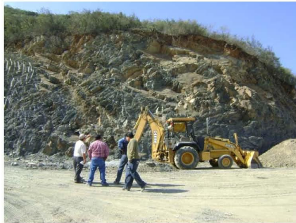
Fotografía 7.5.7.2.5. Talud en el fraccionamiento.
