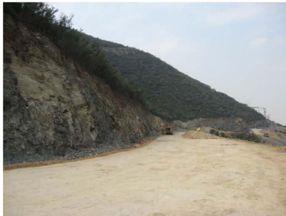
Fotografía 7.5.7.2.8a. Vista de talud.
