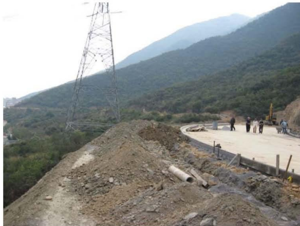
Fotografía 7.5.7.2.8e. Vista de talud.
