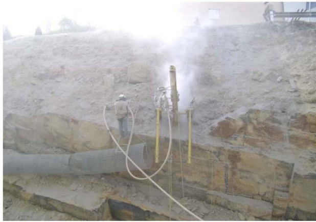
Fotografía 7.3a. Trabajos de perforación para la colocación de las anclas propuestas.
