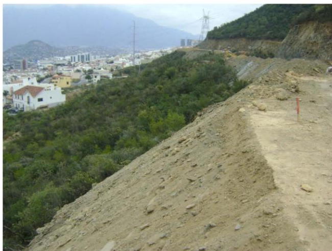
Fotografía 7.5.7.2.4. Talud en vialidad.
