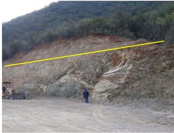
Fotografía 7.5.7.2.6.2. Nivel de la terraza propuesta para incrementar la estabilidad del talud.
