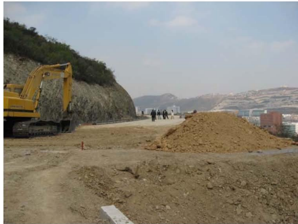
Fotografía 7.5.7.2.8f. Vista de talud.
