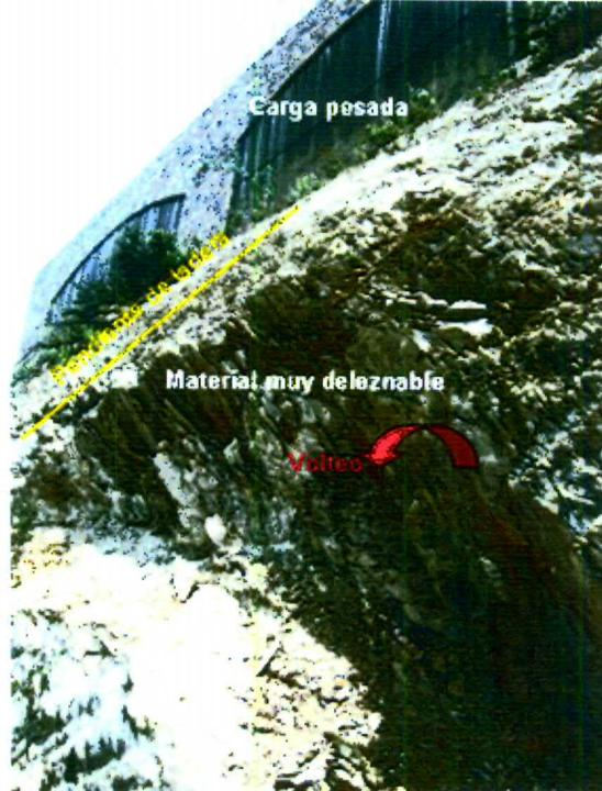
Fotografía 14. Áreas en alto riesgo dada la presencia de material muy intemperizable
