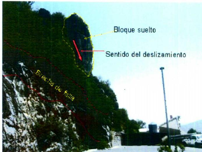
Fotografía 15. En el Cerro de La Corona, aparecen brechas que rellenan una falla, y un gran bloque en posición inestable; todo lo cual conforma una situación de alto riesgo.
